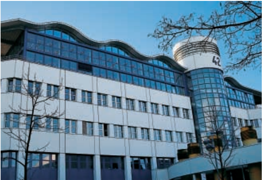
Abb.: Das Gebäude 42 beherbergt die Bereichsbibliothek Maschinenbau und Verfahrenstechnik / Wirtschaftsingenieurwesen
