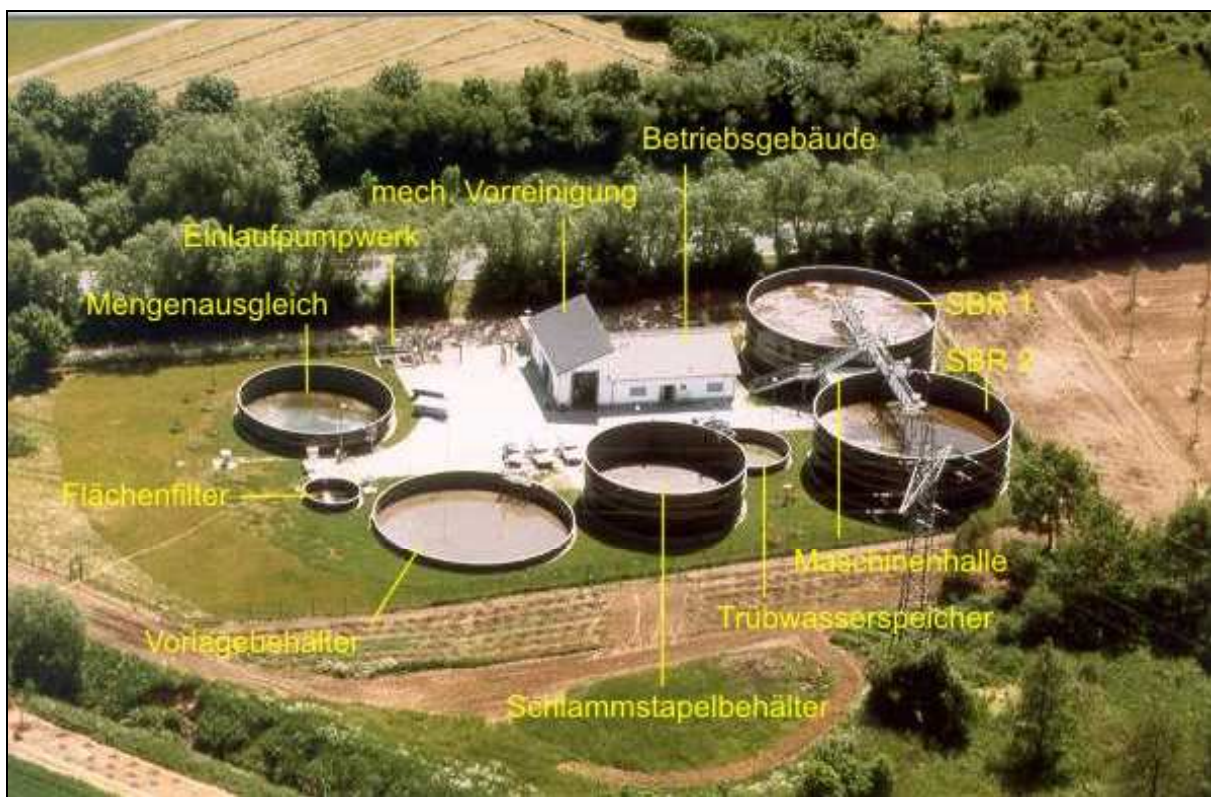
Abb. 4.2: Luftbild der SBR-Kläranlage Messel (Quelle: EAG)
