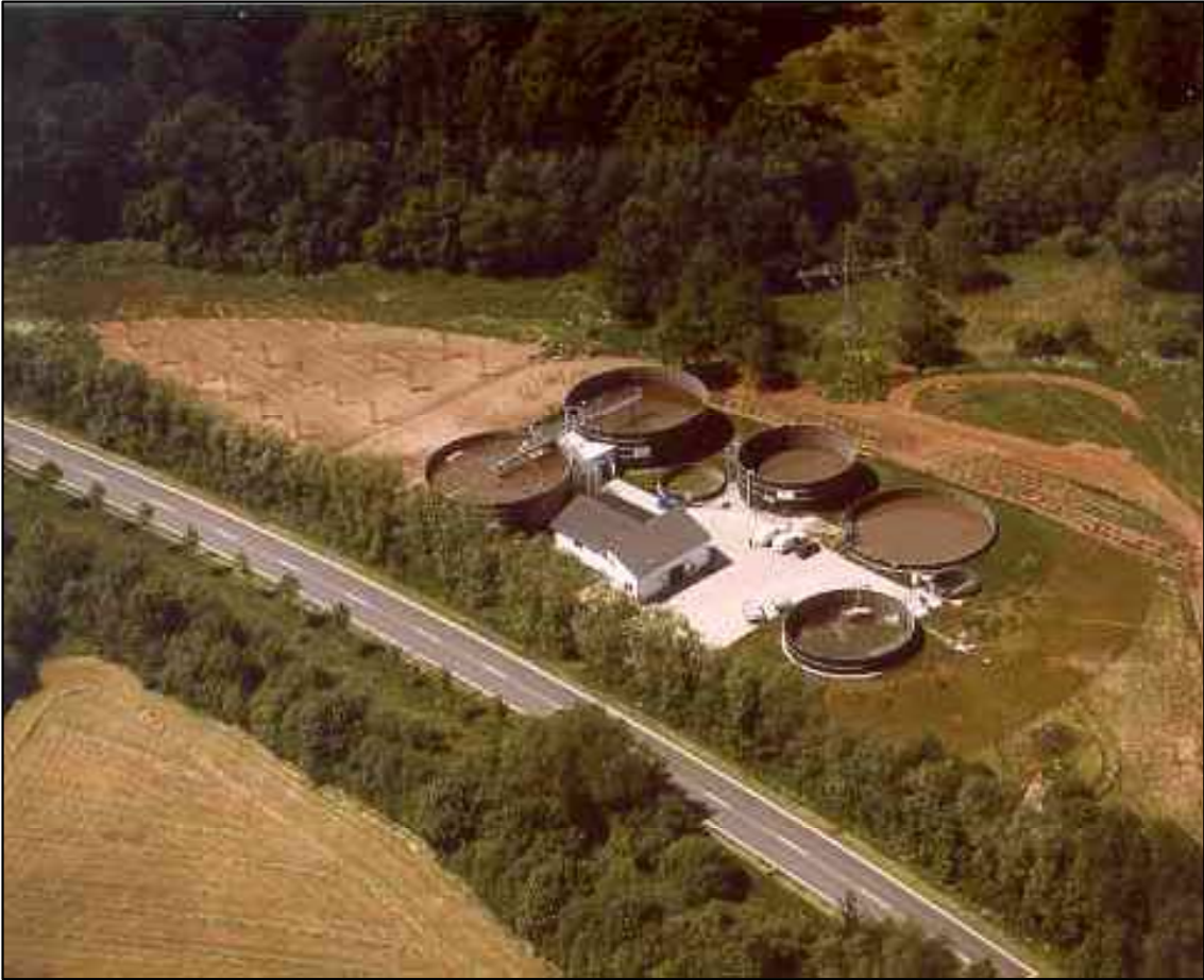
Anh. 4.8: Luftbild der Kläranlage Messel (Quelle: EAG)
