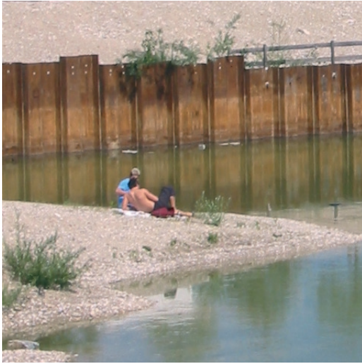
Baugrube (Zustand 2004) für Skylinetower von Helmut Jahn
