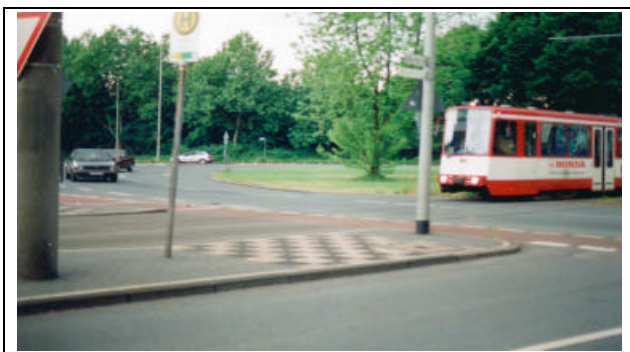
Abbildung 45: Vorfahrtgeregelte Querung der Kreisfahrbahn, die Stadtbahn fährt mit verminderter Geschwindigkeit (Duisburg - Kasslerfelder Kreisverkehr)
