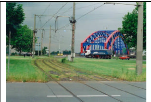
Abbildung 42: Duisburg, Kasslerfelder Kreisverkehr, vorfahrt-geregelte Straßenbahnquerung
