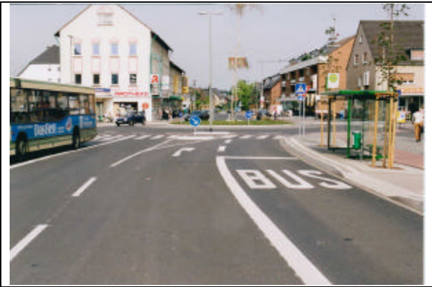
Abbildung 118: Eingezogene IV-Spur, Fortführung der ÖV-Spur
