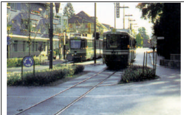
Abbildung 48: Kreisverkehr in Wabern (CH) mit Mittelinselquerung
