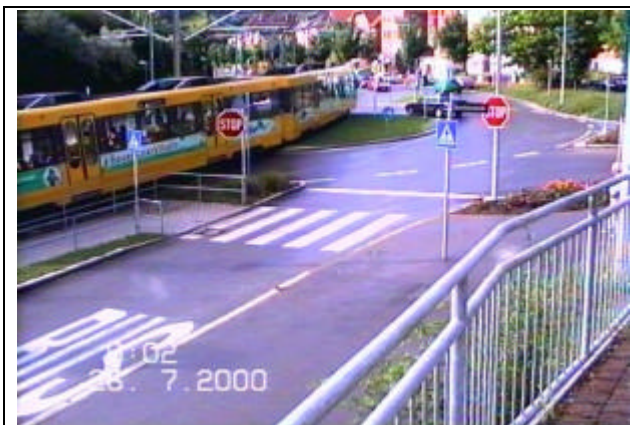
Abbildung 46: Kreisverkehr mit Straßenbahnüberfahrt in Mittellage (Stuttgart)
