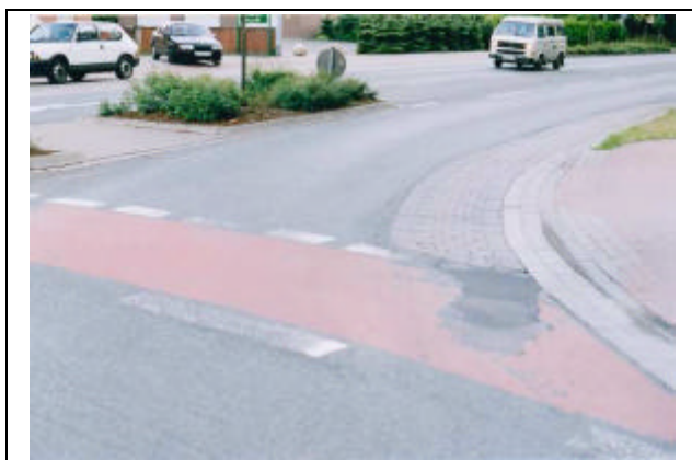
Abbildung 79: Verbreiterung in Zufahrt zur Sicherstellung der Schleppkurven, Vergrößerung des Ausfahrtradius, gepflastert (Kreis Steinfurt)
