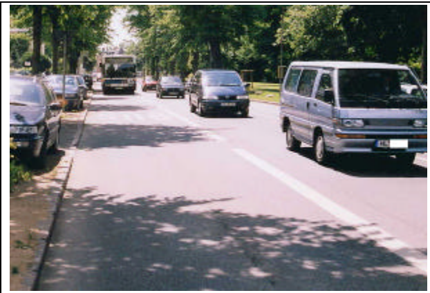
Abbildung 56: ÖV-Spur in Seitenlage, Lübeck, Mühlenortplatz, der Bus kann an sich aufstauenden MIV-Fahrzeugen vorbeifahren
