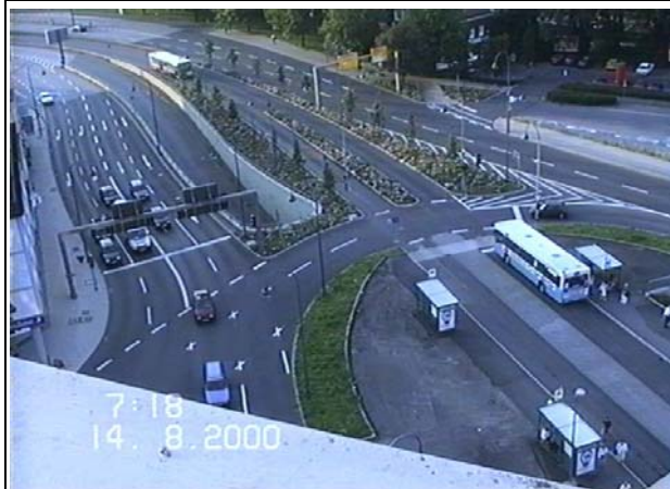
Bild - A 33: Zufahrt Bismarckstraße Ost
