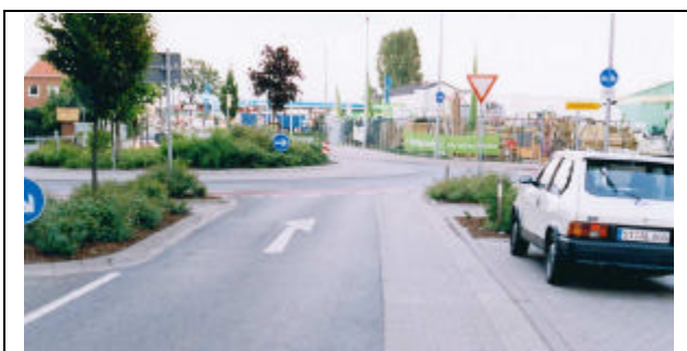
Abbildung 66: Verbreiterung in Zufahrt zur Sicherstellung der Schleppkurven, gepflastert (Ibbenbüren)
