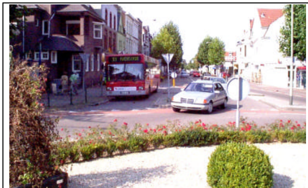
Abbildung 55: Haltestelle vor der Kreisfahrbahn mit eigener Einfahrt (Waals / NL)
