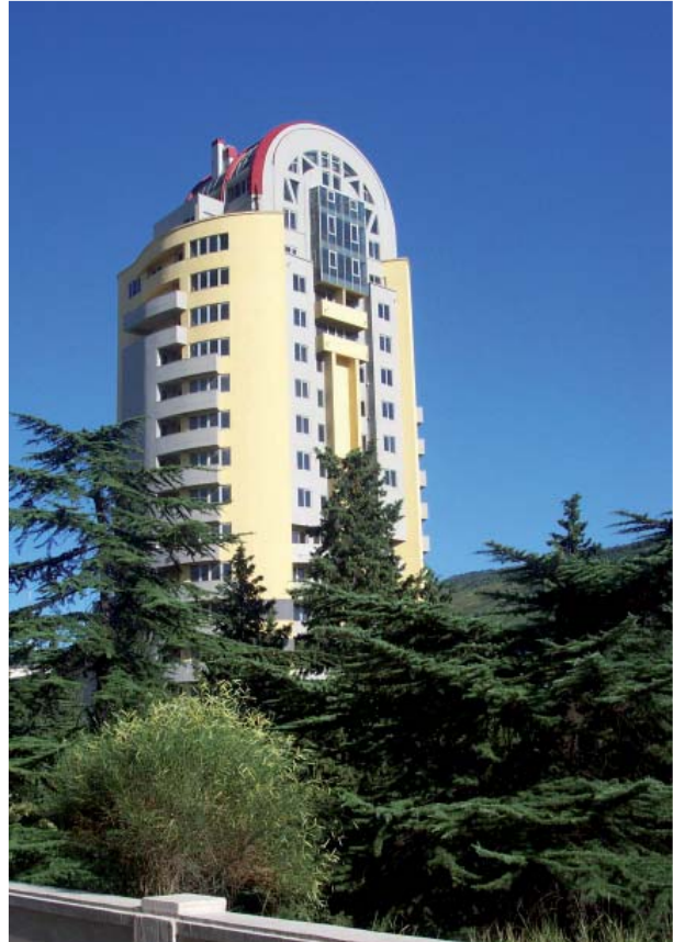
Bild 98: Neues Hochhaus am Rande des öffentlichen Wakeparks, 2005
