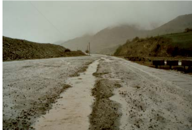
Bild 39: Mit PKW kaum befahrbar - Zustand der Grossen Heeresstraße im Jahr 2002
