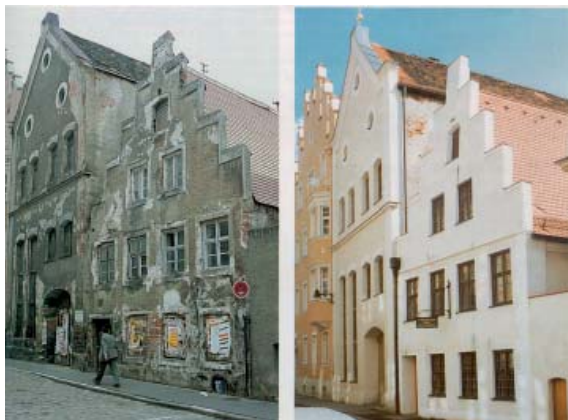
Bilder 121-122: Altbausaniierung zum Erhalt historischer Ortskerne - Beispiel Ingolstadt, Quelle: Bayerisches Staatsministerium des Innern Oberste Baubehörde, Städtebau und Städtebauförderung in Bayern Nr. 5, S. 45
