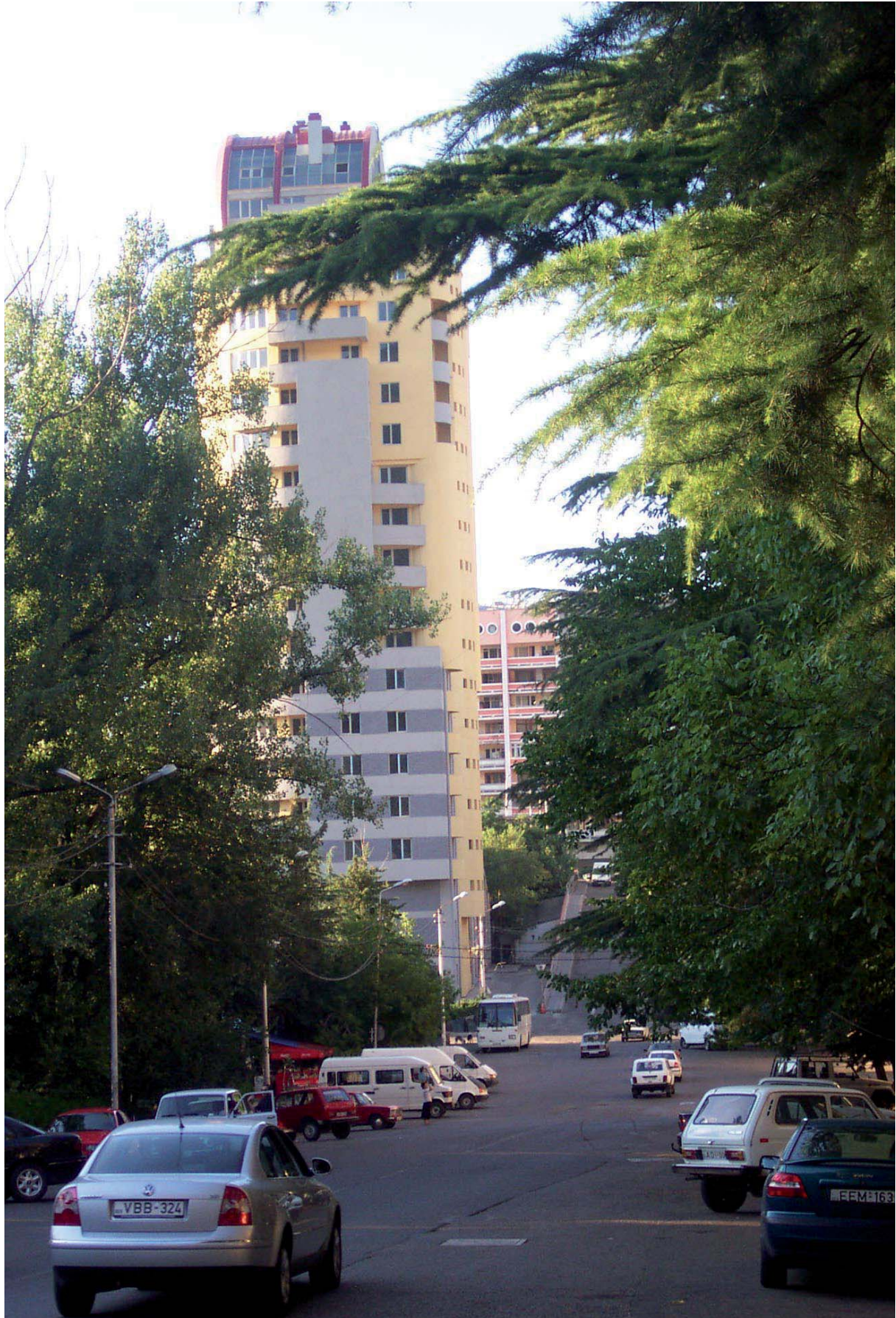
Bild 104: Beispiel zu Regelfall 4: Wake-Park - Ein neues Hochhaus wird am Rande des Wake-Parkes auf Parkflächen errichtet, 2005
