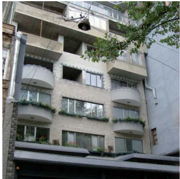
Bild 111: Altstadt Kala/Sololaki - Dieses Gebäude fügt sich weder von der Bautypologie noch vom Maßstab in die historische Bebauung ein, 2003
