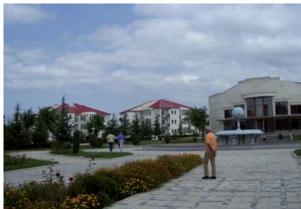
Bilder 146 und 147: Seit mehreren Jahren im Bau: Clubanlkage am Basaletisee, 2005
