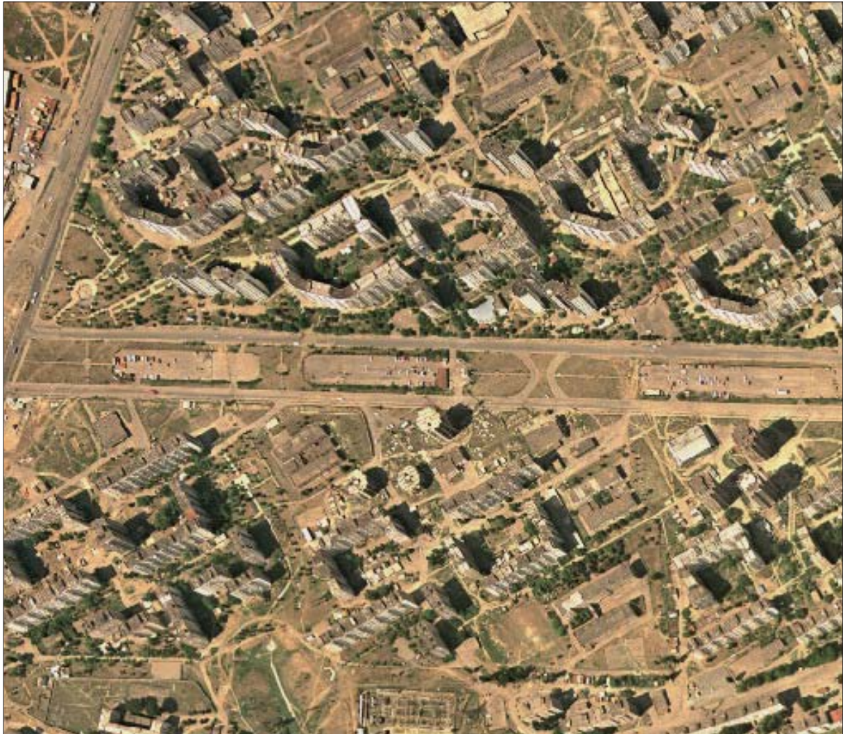
Bild 124: Schnell errichteter Hochhauskomplex ohne urbane Raumqualitäten - Beispiel Varketeli 80er Jahre
