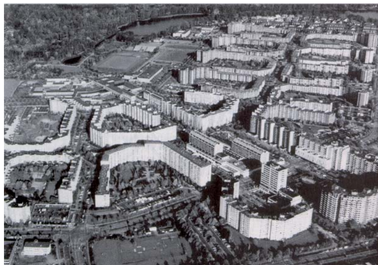
Abb. 37 und 38: Großstrukturen mit Hochhäusern - Beispiel Hamburg-Steilshoops, 70er Jahre, Quelle: Reinborn, S. 265/266
