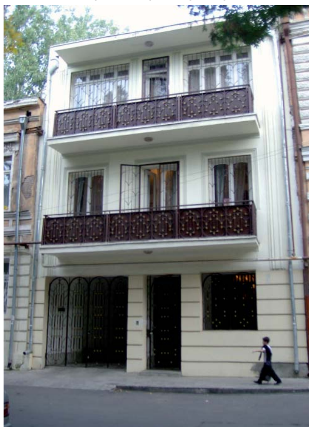
Bild 115: Kala - Positives Beispiel eines Neubaus in der Altstadt, 2003
