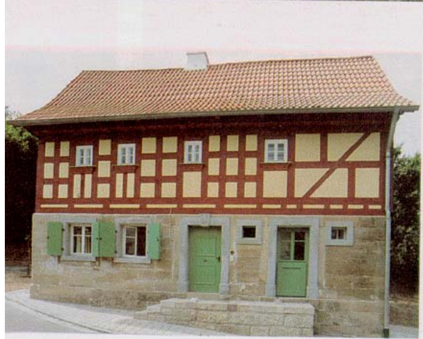
Bilder 119-120: Beispiel einer sensiblen Altbausaniierung, Quelle: Oberste Baubehörde im Bayerischen Staatsministerium des Inneren, Städtebauförderung in Bayern Nr. 12, S. 25
