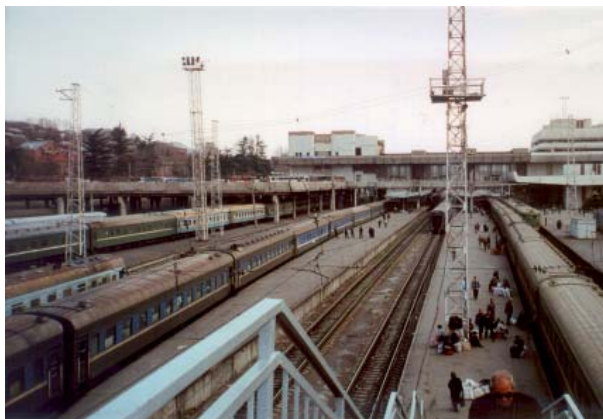
Bild 11: Ganztägig abgestellte Züge im Hauptbahnhof von Tbilisi, 2005
