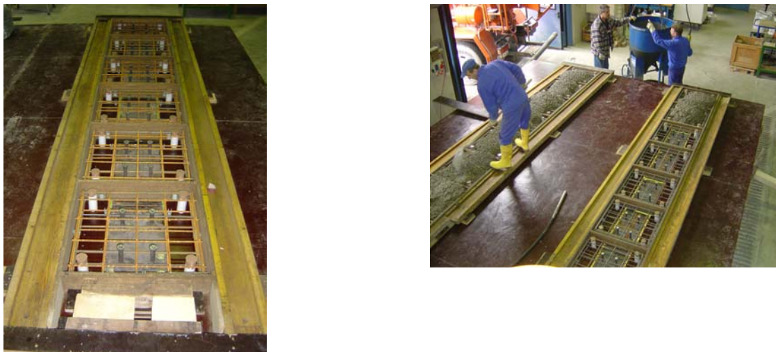
Bild 3.8 Betoniervorgang, Schalung, Bewehrung und Stahl
