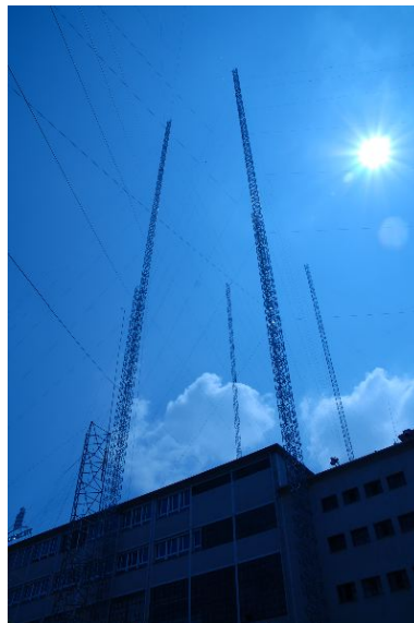
Abbildung 116: Baugespann „prime Tower“ in Zürich [UmweltNetz (2007)]
