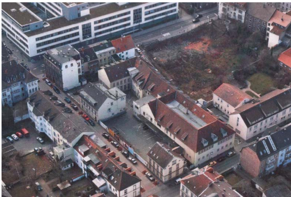
Abbildung 131: Luftbild Glockencarré im Zustand der Baubrache [GLT (2007)]
