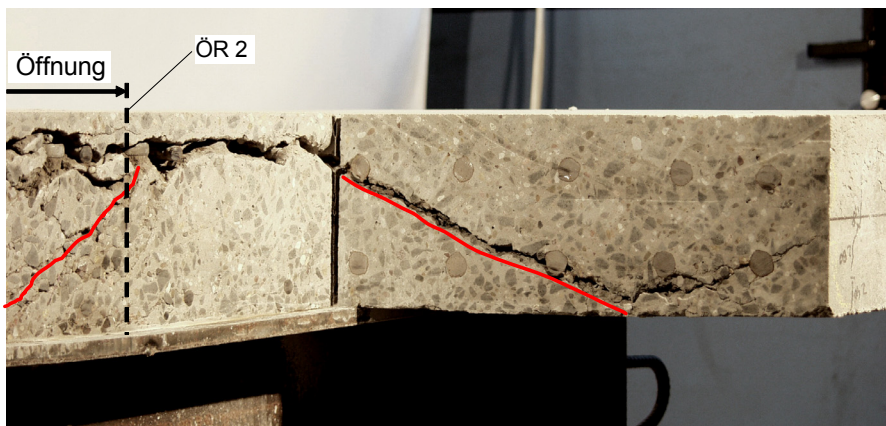
Abb. 5.26: Geometrie des Ausbruchkegels bei Versuch T1N
