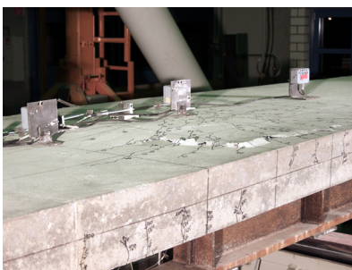
A: Schräge Seitenansicht der Betongurtoberseite
