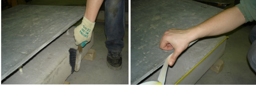
Abb. 5.5: Anbringen des elastischen, beidseitigen Klebebandes an der Fassadenplatte
