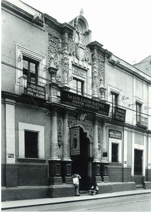
Foto 2: Fachada principal, estado antes de 1935 (Archivo fotográfico del INAH)
