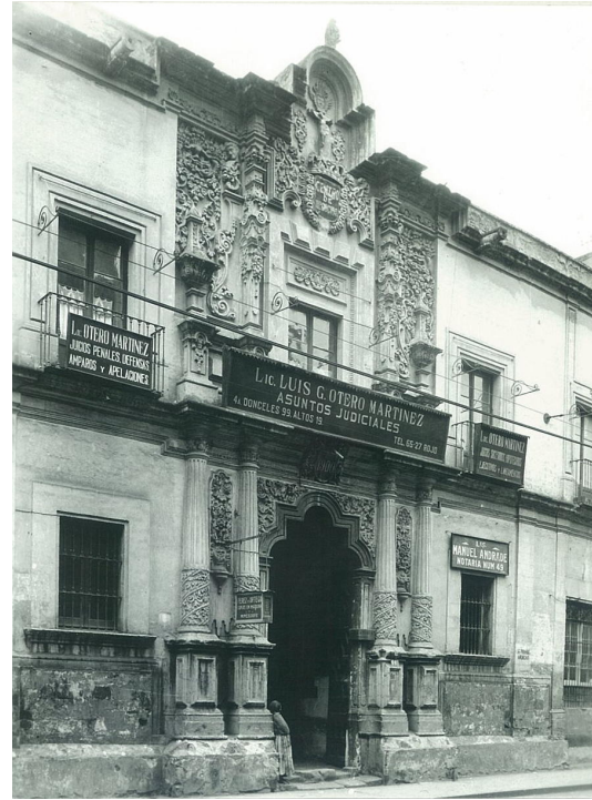
Foto 3: Fachada principal, estado antes de 1935 (Archivo fotográfico del INAH)
