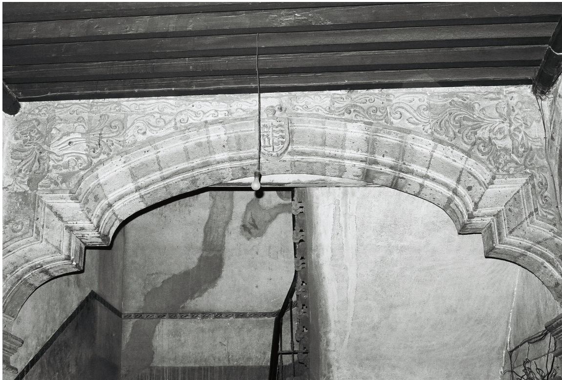
Foto 17: Arco del cubo de la escalera (1980)
