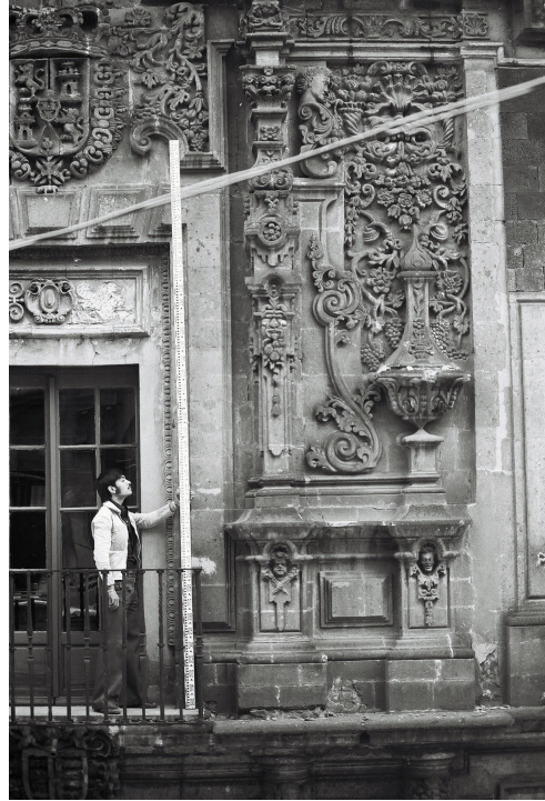
Foto 9: Detalle de la fachada, registro superior (24 de abril de 1980)
