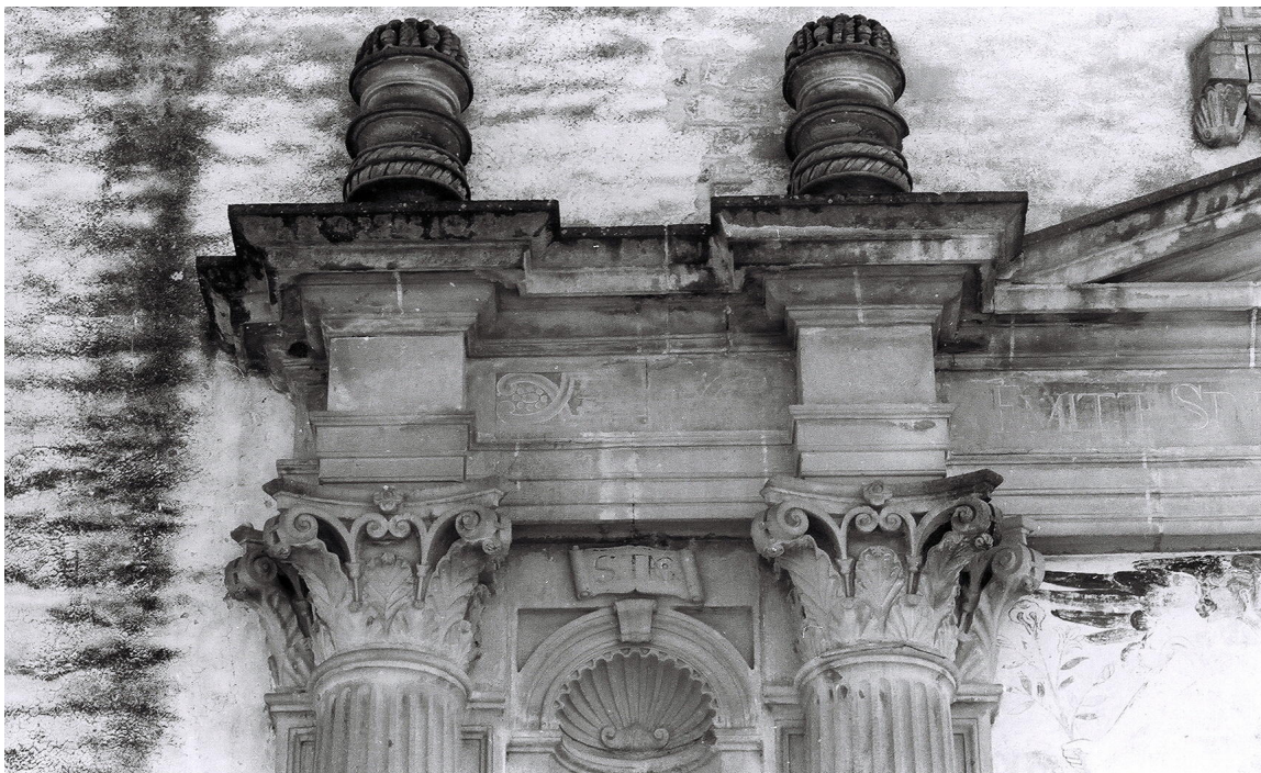
Figura 51: Capiteles y entablamento de la portada principal de la basílica de Tecali, Pue. (Foto del autor)
