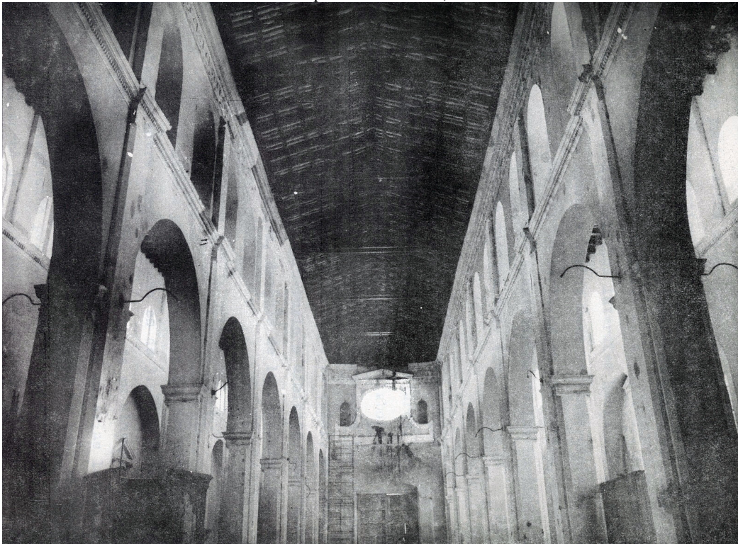
Figura 47: Interior hacia el coro, del mismo edificio (Foto de José Luis Espinosa Cervantes)
