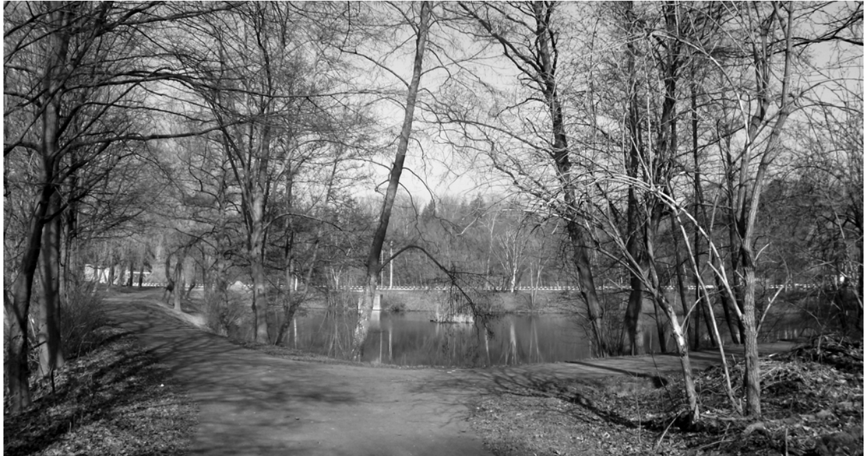
Abb. 32: Regenrückhaltebecken am Gewerbegebiet Kléber
