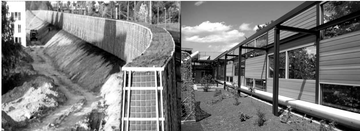
Abb. 42: Beispielfotos von Lärmschutz
