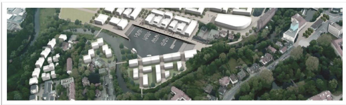
Abb. 13: Dreidimensionale Planungsvisualisierung und deren lagetreue Einbindung in ein Luftbild (mess / Mobile Einsatztruppe Stadt und Stil [n.b.])
