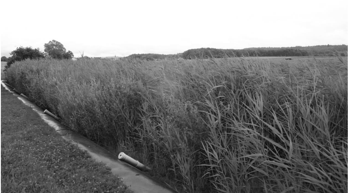
Bild A9.10: Kläranlage Oberleuken - Hauptbodenfilter im Juni 2007
