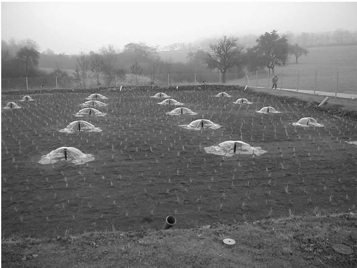
Bild 2.3: Beschickungssystem der HBF der Kläranlage Büschdorf (Drescher, Hasselbach, Rampendahl 2007)
