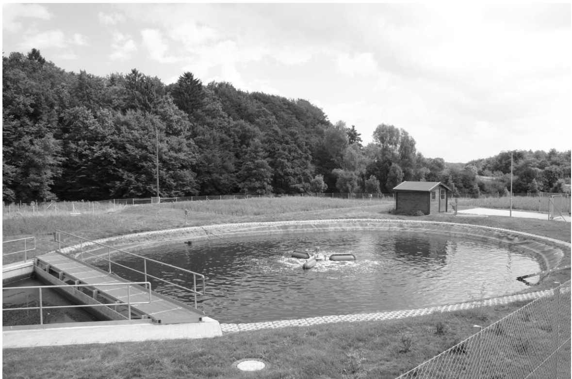
Bild A9.2: Kläranlage Büschdorf - Vorteich im Juli 2005
