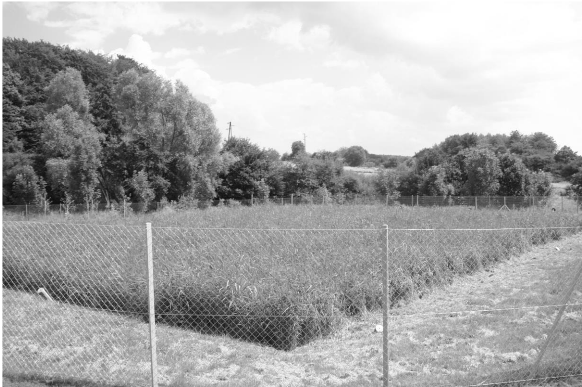
Bild A9.3: Kläranlage Büschdorf - Hauptbodenfilter im Juli 2005
