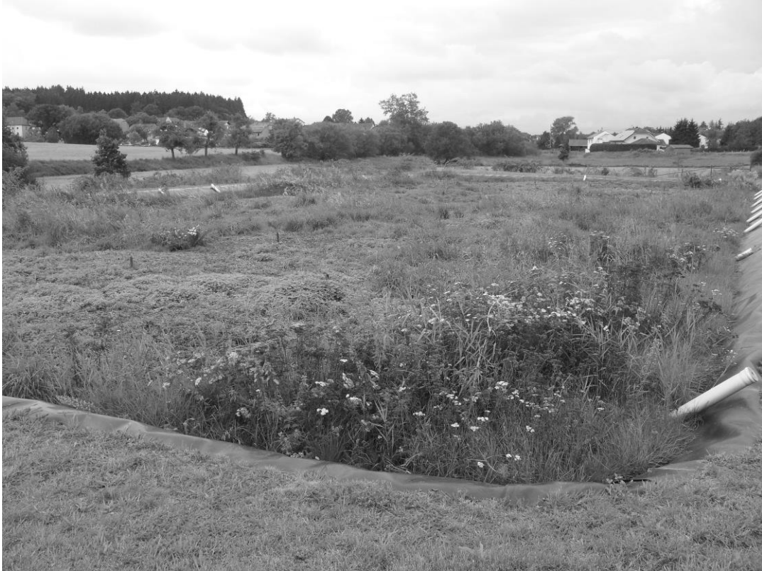
Bild A9.11: Kläranlage Oberleuken – schlechter Bewuchs Hauptbodenfilter im August 2011
