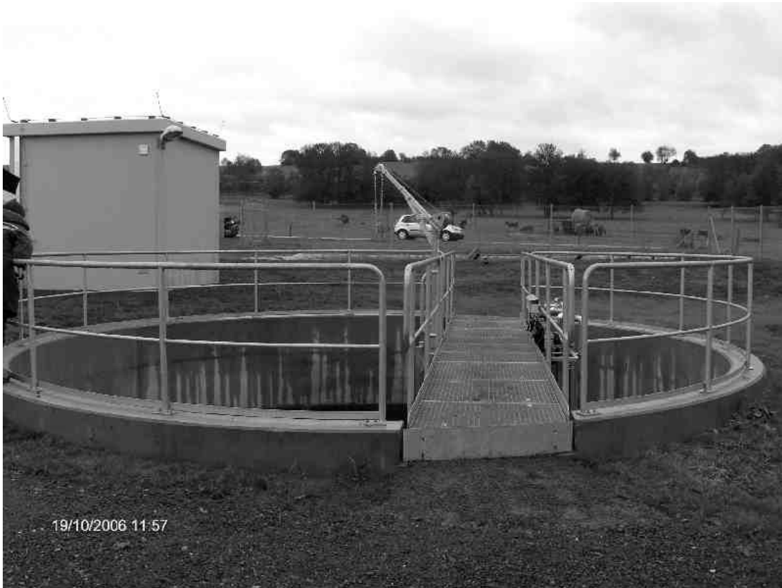
Bild A9.13: Kläranlage Utweiler – Mehrzweckbecken im Oktober 2006
