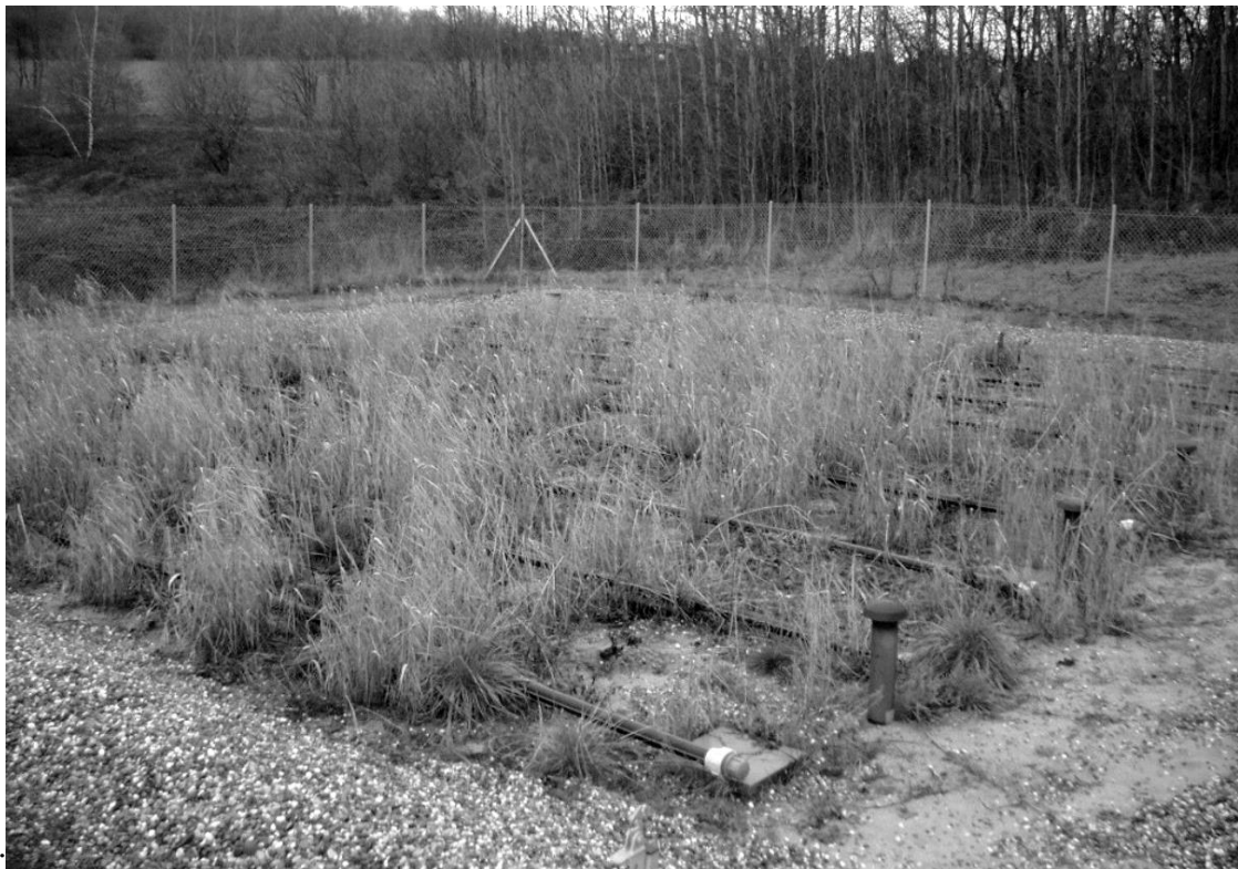
Bild 4.7: Vertikalfilter und Beschickungssystem der Kläranlage Vogelsbüsch
