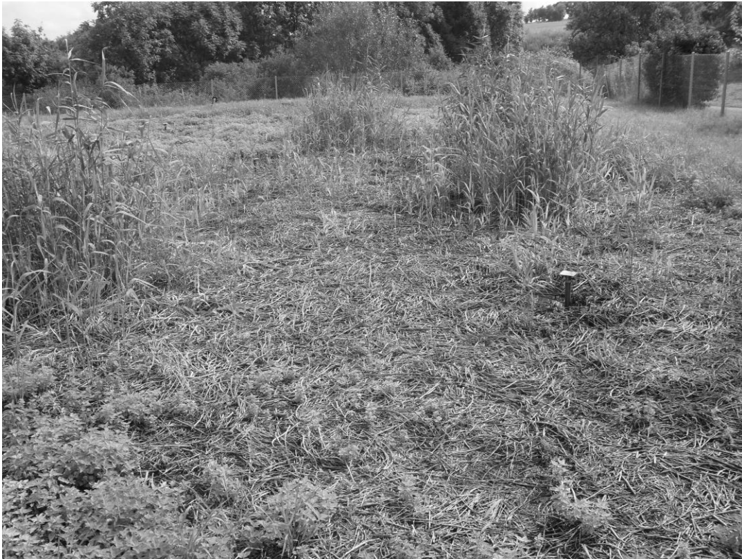
Bild A9.7: Kläranlage Büschdorf – schlechter Bewuchs Hauptbodenfilter im August 2011
