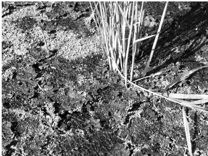
Bild 5.40: Sekundärfilter auf der Bodenfilteroberfläche der Kläranlage Riesweiler nach Beendigung des Einstaubetriebs im Jahr 2008 (Bruch, Alewell, Hasselbach 2011)
