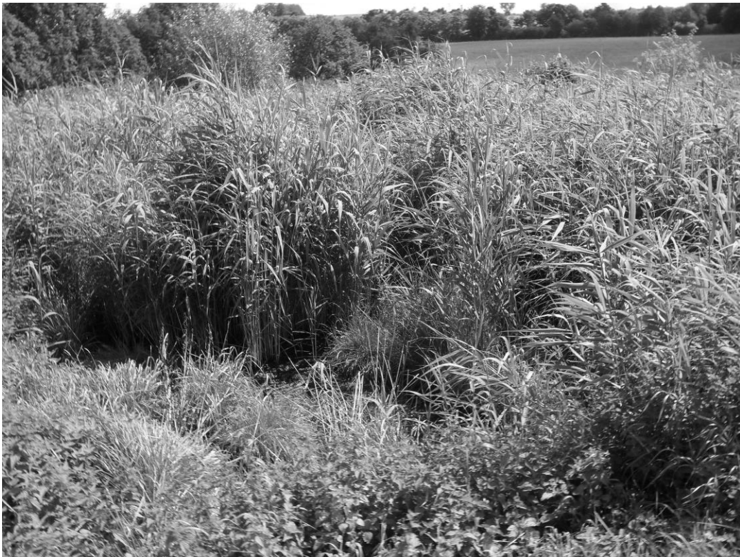
Bild A9.8: Kläranlage Büschdorf –Bewuchs Hauptbodenfilter nach Einstauphasen im August 2012
