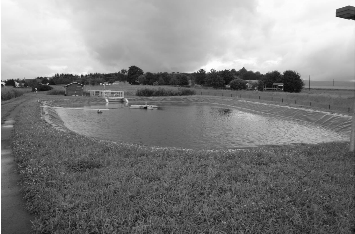
Bild A9.9: Kläranlage Oberleuken - Vorteich im Juni 2007
