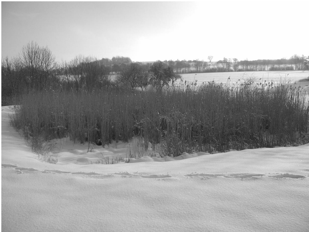
Bild A9.4: Kläranlage Büschdorf –Hauptbodenfilter im Januar 2013
