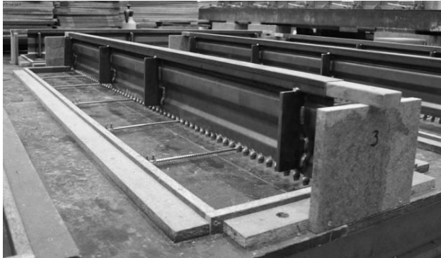
Abb. 6-10: Schalung eines Verbundträgers
