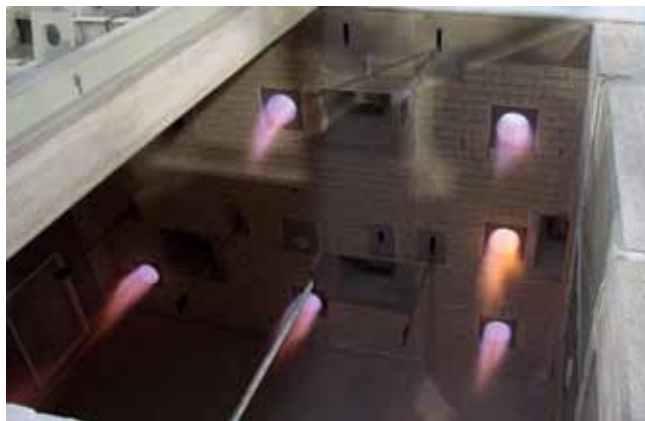
Probetrieb des neuen Brandofens
