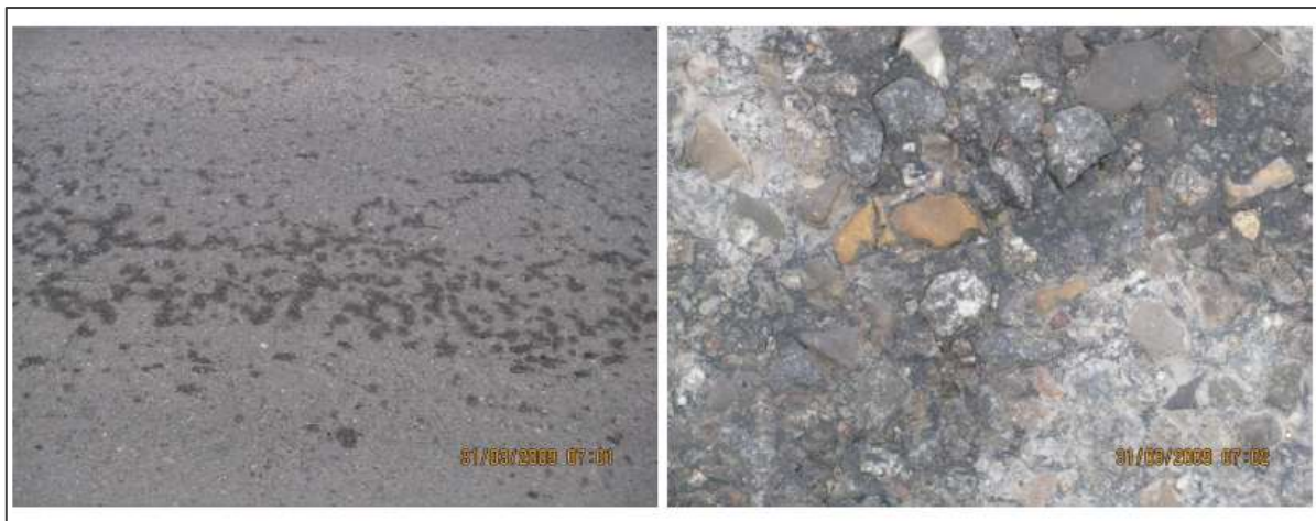
Bild 2-13: Dokumentation von „Salzflecken“ und die Auswaschung von Feinpartikeln aus dem Fahrbahnmaterial als Folge der Salzstreuung [Lambert, 2010]
