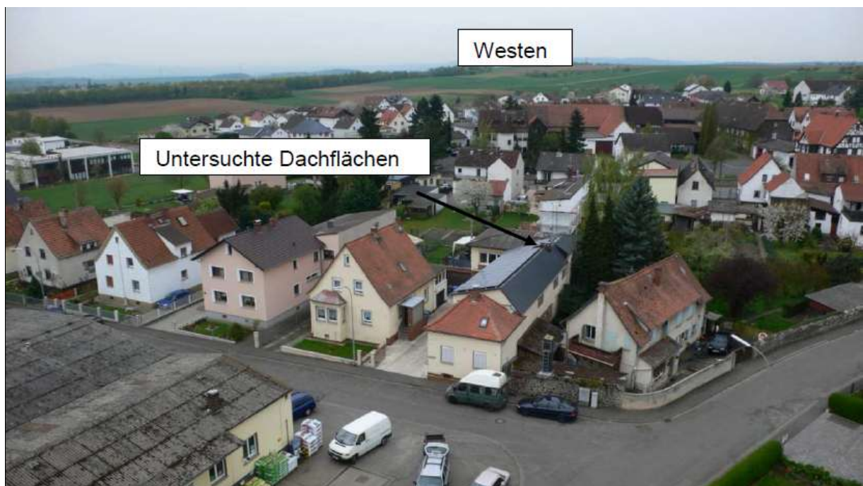
Bild 3-7: Lage des untersuchten Daches [Kreiling, 2012]
