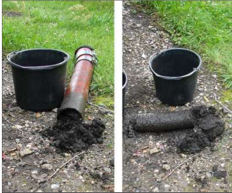
Bild 2-28: Dachrinnenreinigung. Quelle: [Dachrinnenreinigung Seyffarth, 2013]
