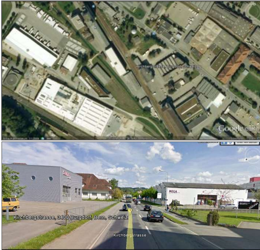
Bild 5-3: Situation in der Kirchbergstrasse, Burgdorf, Quelle: google-earth
