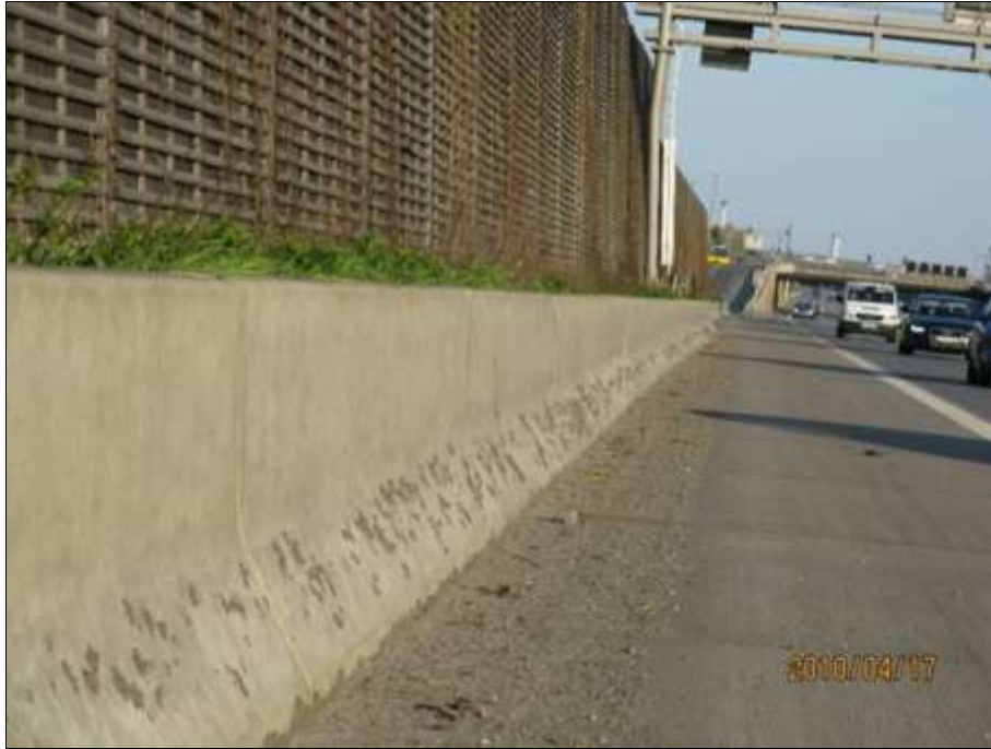
Bild 2-24: Vermehrte Sedimentbildung am Hochbord der A113neu in Berlin nach der Wintersalzung, Frühjahr 2008. Aus: [Lambert, 2011]
