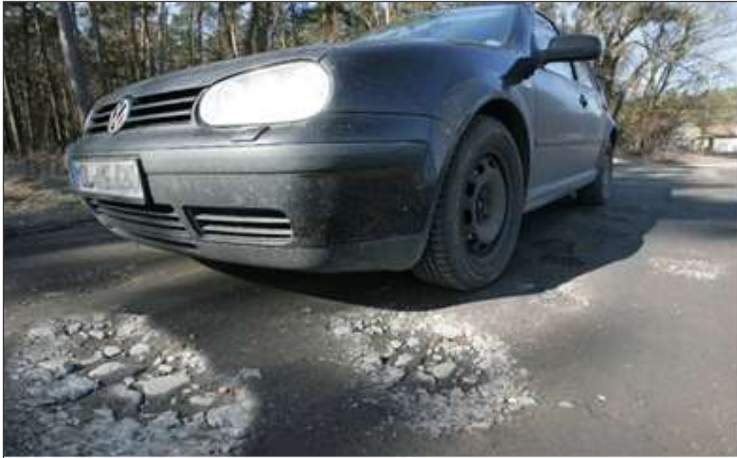
Bild 2-12: Fahrbahnzerstörung nach dem Winter, Foto: [Markert, 2012]
