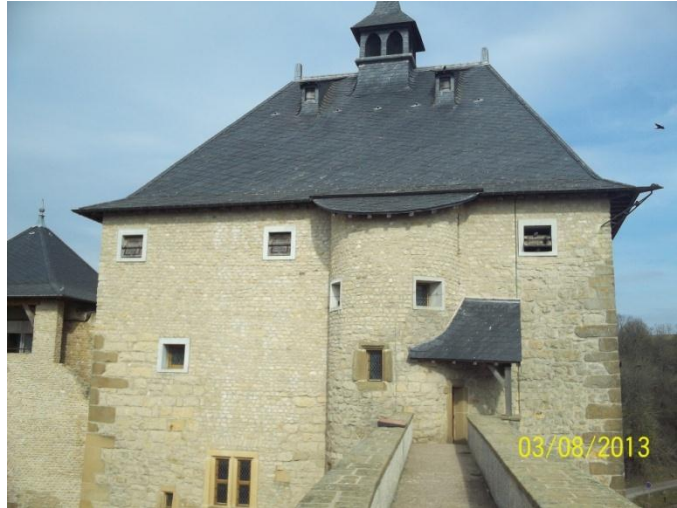
Abbildung 6: Blick über die Mauer des Haupteingangs
