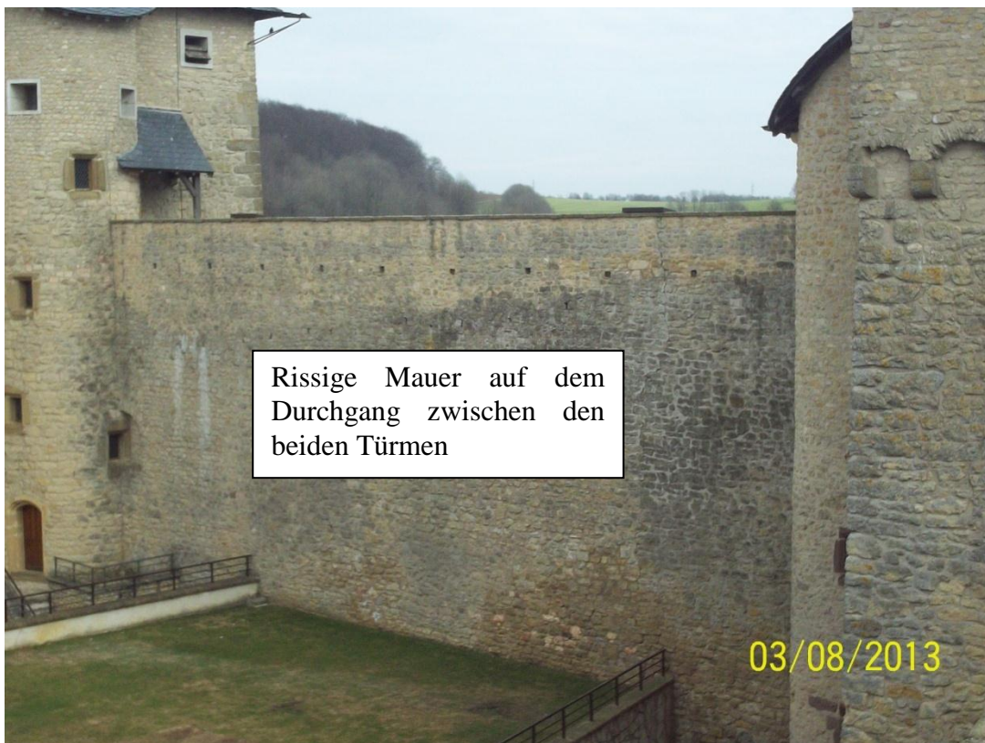
Abbildung 5: Hofseitige Mauer zwischen den 2 Türmen
