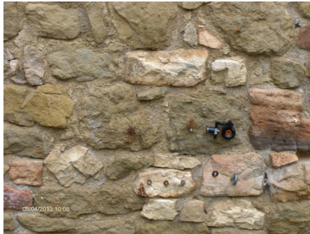
Abbildung 9: Zoom auf die Vermessungsprismen
