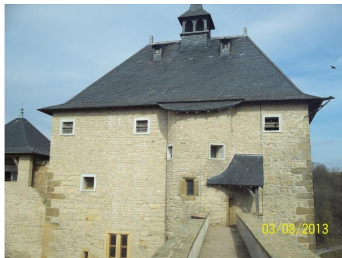
Figure 6 : Vue au-dessus du mur de l'entrée principale
