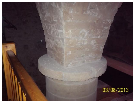
Figure 4: Fondation de la tour des lanternes
