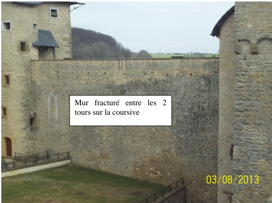
Figure 5: Mur côté cour entre les 2 tours
