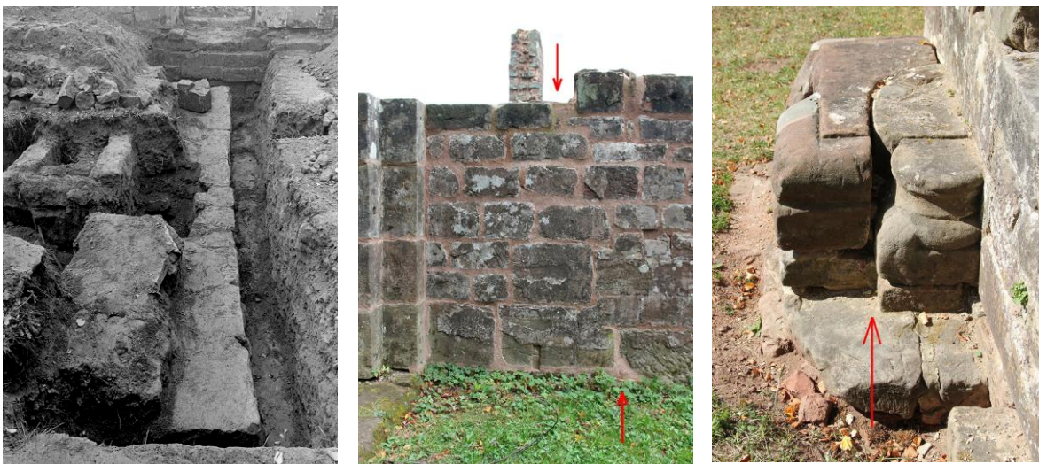
Abb. 4-6: Links: Grabungsfoto 1957 mit Mauerzügen einer benediktinischen Vorgängerkirche (Foto: Harald Boockmann Nr. P59), Mitte: Nordmauer mit Baufuge als Hinweis für Bauunterbrechung, rechts: vorgesetzter
