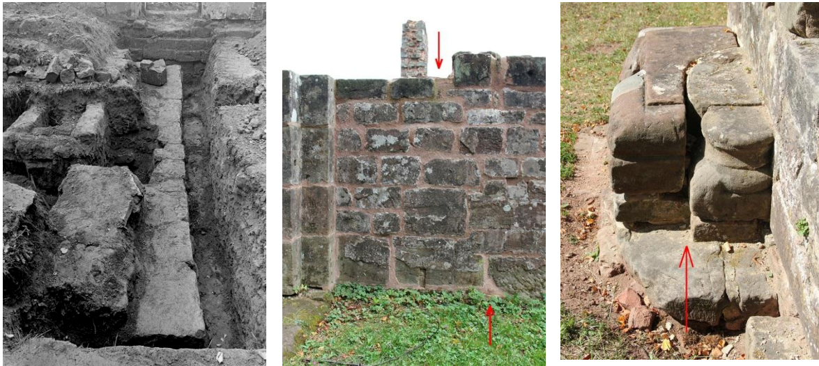
Images 4-6 : à gauche : photo des fouilles de 1957 avec des tracés de murs datant de l'église précédente bénédictine (photo : Harald Boockmann n°. P59), milieu : mur nord avec joint entre deux sections de murs indiquant une interruption lors de la construction, à droite : pilier placé devant un mur sur base de modèle attique indiquant une modification du plan (photos couleurs de l'auteur).
