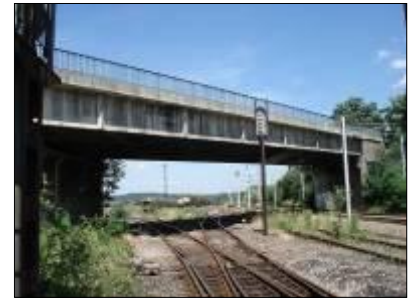
Figure 2. Photo de l'élevation de l'ouvrage
