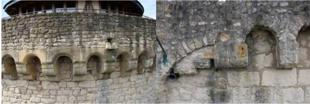
Abbildung 4: Links: UAS-Nahaufnahme, Tour des Dames, Nordseite. Rechts: UAS-Detailaufnahme, Verbindungsmauer Westseite
