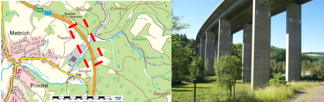
Abbildung 9: Links: Kartenansicht der Mettnicher Talbrücke. Rechts: Foto der Mettnicher Talbrücke
