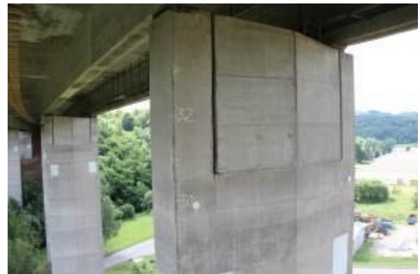
Abbildung 11: UAS-Luftbild des Brückenpfeilers 5, Nordansicht
