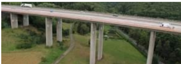
Abbildung 12: UAS-Höhenaufnahme der Mettnicher Talbrücke
