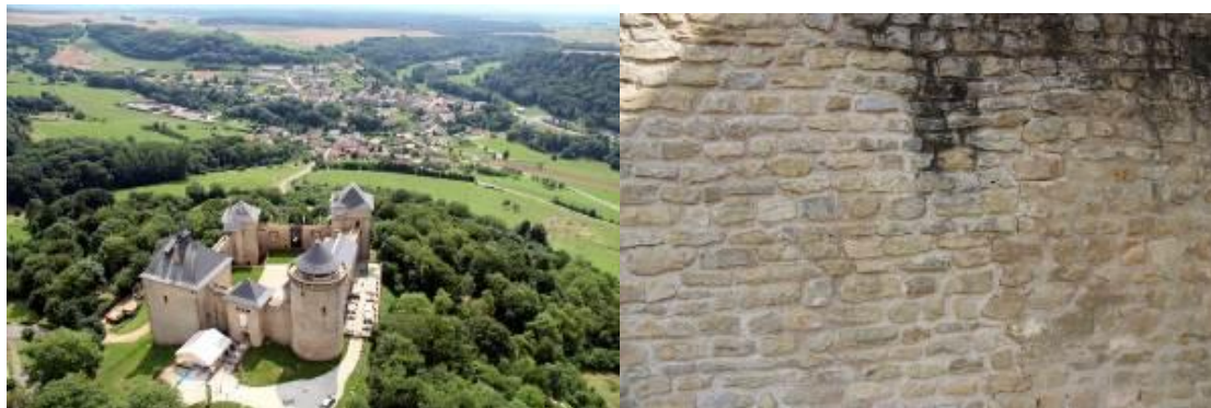
Abbildung 3: Links: UAS-Höhenaufnahme des Château de Malbrouck mit Blickrichtung Süden. Rechts: UAS-Nahaufnahme im Innenhof Eingangsbereich
