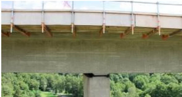
Abbildung 10: UAS-Luftbild der Südwestseite oberhalb Pfeiler 5
