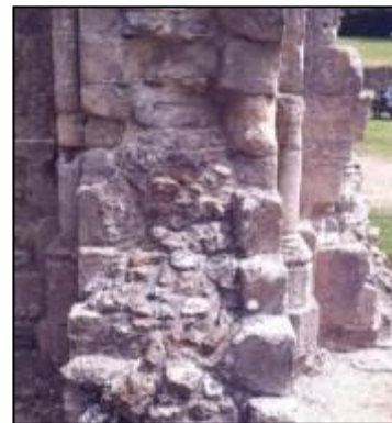
Abbildung 17: Links: schematische Darstellung des Mauerwerksaufbaus. Rechts: Beispiel einer realen Mauer mit einer solchen Struktur (Foto rechts, Herr Strauss)
