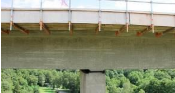
Fig. 10 : Prise de vue aérienne UAS du côté sud-ouest au-dessus du pilier 5
