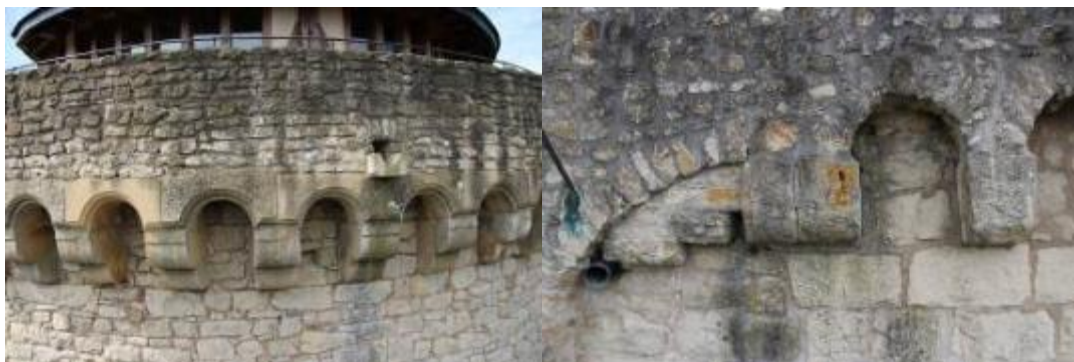
Fig. 4 : À gauche : Gros plan UAS, Tour des Dames, côté nord. À droite : Détail pris par UAS, mur de liaison côté ouest
