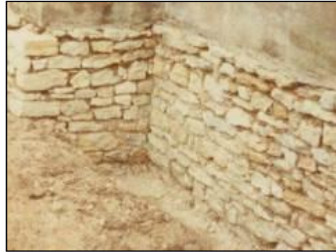
Fig. 14 : À gauche : Vue de l'entrée de l'église de Rilchingen-Hanweiler ; à droite : Photo du mur déchaussé pendant un assainissement. (photo à droite : Monsieur Strauss)
