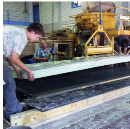
Abb. 5.74: Einheben des XPS-Kerns in den Beton am 2. Herstellungstag
