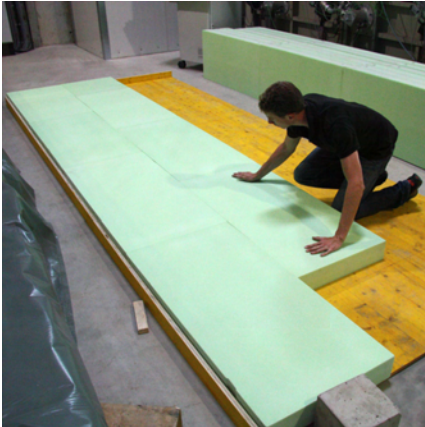
Abb. 5.71: Zusammenkleben und Ausrichten der XPS-Platten
