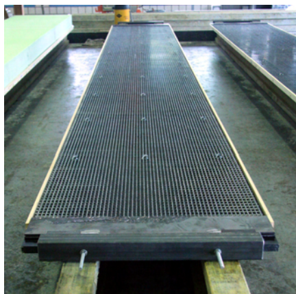
Abb. 5.53: Vorbereitete Schalung mit Carbonbewehrung
