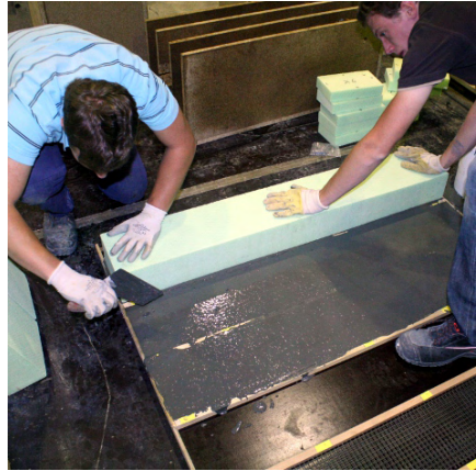
Abb. 5.7: Eindrücken und Ausrichten des XPS-Kerns
