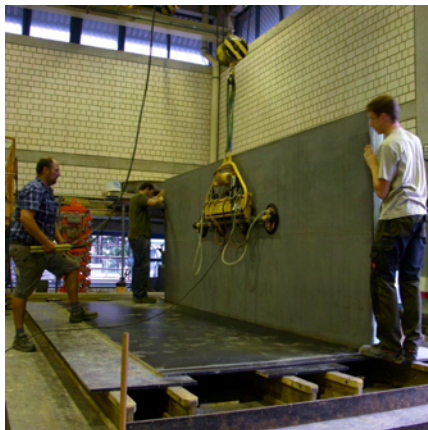
Abb. 5.73: Anheben des Wandelements mithilfe des Vakum-Glassaugers
