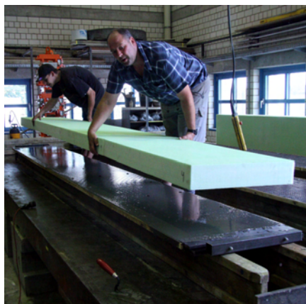
Abb. 5.55: Auflegen des XPS-Streifens auf den Frischbeton
