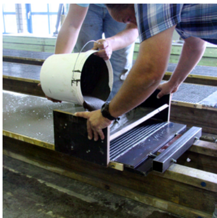
Abb. 5.54: Einbringen des Betons in die Schalung
