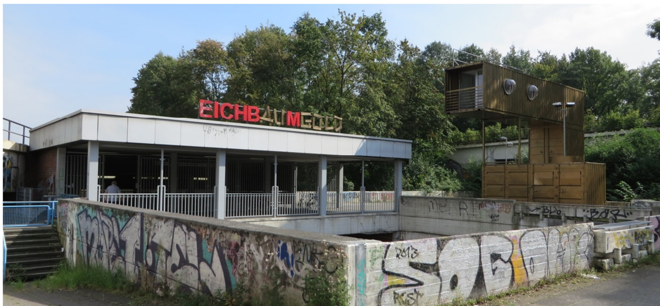
Abb. 43: Station Eichbaum 2014 – die Spuren der Eichbaumoper sind noch erkennbar
