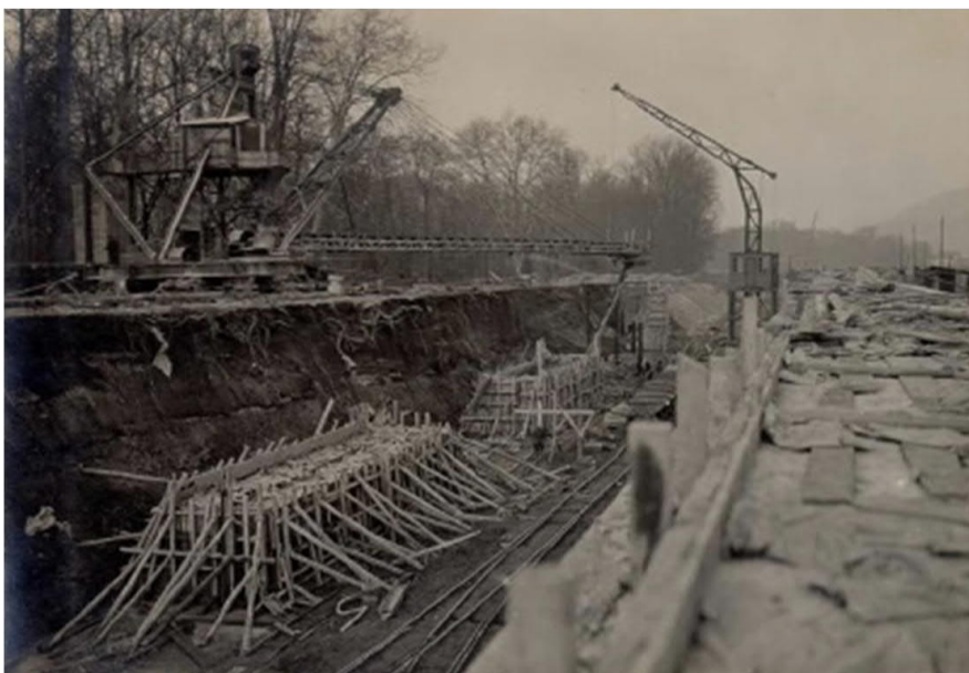
Bild 8.1: Bau der Schleusen- kammer in lagen- und lamellenweiser Blockbauweise. Betonfördereinrich- tung, eingeschalter Block der landseiti- gen Kammerwand, Nachbehandlung der Betonober- fläche der flusseiti- gen Kammerwand, Staustufe Heubach [BAW - 2005]
