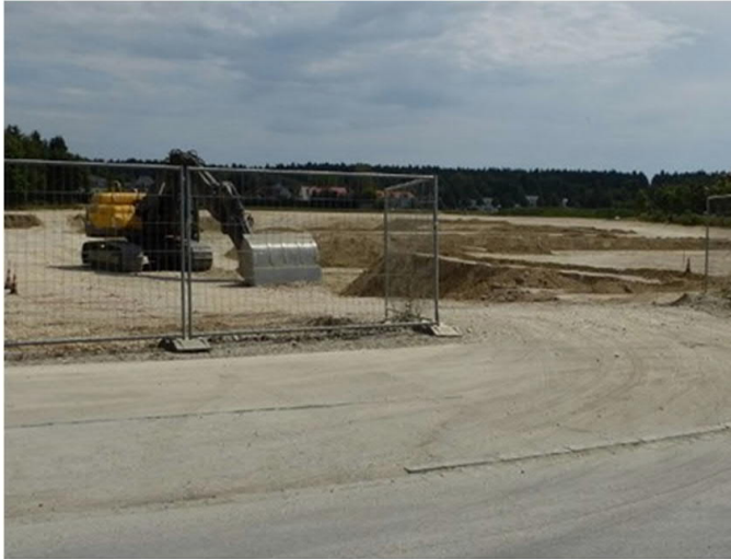
Bild 10.4: Baufeld zur Errichtung eines Neubaus
