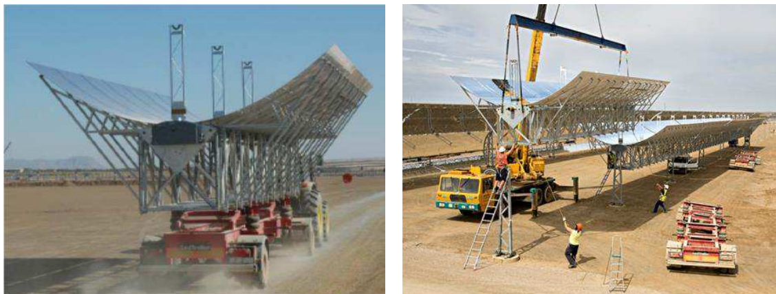
Abb. 2.10: Transport eines montierten Kollektorsegments in das Solarfeld und anschließende Montage (Quellen: rechts: Nava 2007 a, unten: http://paul-langrock.de/docs/andasol.htm , zuletzt zugegriffen am 17.12.2014)
