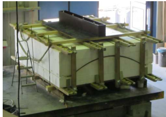
Abb. 8.10: Schalung der Parabolrinne des Großdemonstrators
