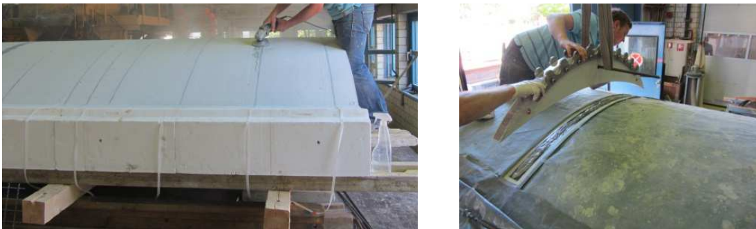
Abb. 8.11: links: Aufrauen der Betonoberfläche, rechts: Verklebung der Auflagerrippen mit der Parabolrinne
