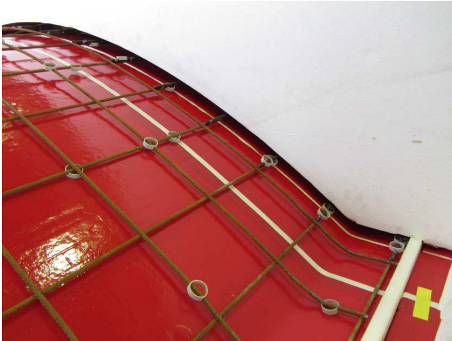
Abb. 8.6: Bewehrung der Parabolrinne und Abstandhalter
