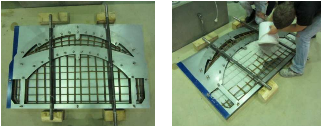
Abb. 8.4: Bewehrung, Schalung und Betonage der Auflagerkonstruktion
