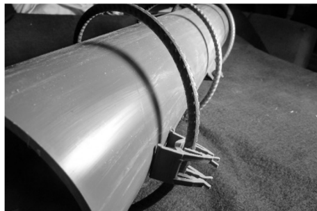
Abbildung 4-12: Befestigung der Wendel mit Betonabstandhaltern an der Leitung
