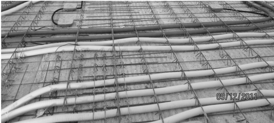
Abbildung 6-1: Beispiel für Leitungen in Elementdecken [www.rauscher-heizung.de (16.06.2016)]
