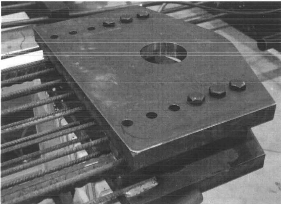
Abb. 35: Lasteinleitungsstruktur Plattenversuche (vor der Betonage)
