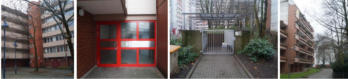
Bild 15: Hauseingangsbereich (l., m. l.), Abfallsammelanlage (m. r.) und Wegeführung (r.) (Immobilie 1)
