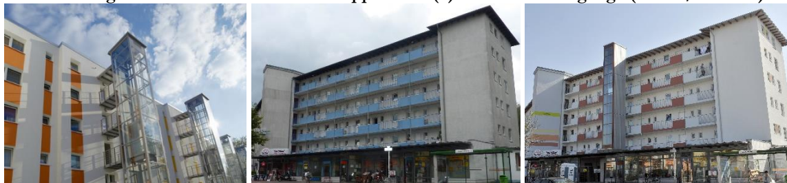
Bild 9: Aufzugsanbau an das bestehende Treppenhaus (l.) und an Laubengänge (vorher/nachher)
