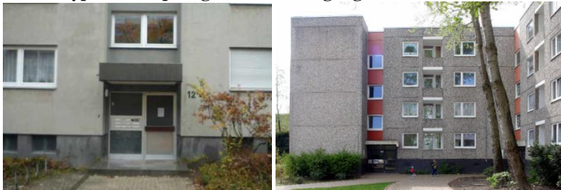
Bild 1: Typische ursprüngliche Hauseingangssituation bei MFH aus den 1970er Jahren
