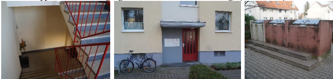
Bild 17: Treppenhaus, Hauseingangsbereich und Abfallsammelanlage (Immobilie 2)
