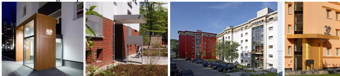
Bild 5: Gestaltungsbeispiele für Hauseingangsbereiche
