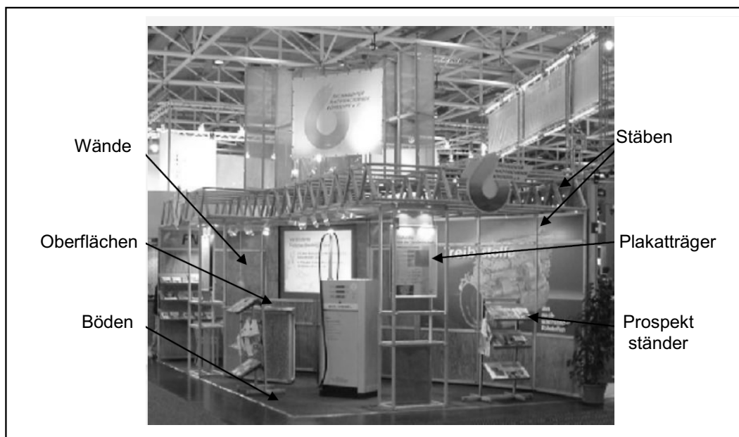
Bild 2.11: Übersicht der Messebauelemente [84]
