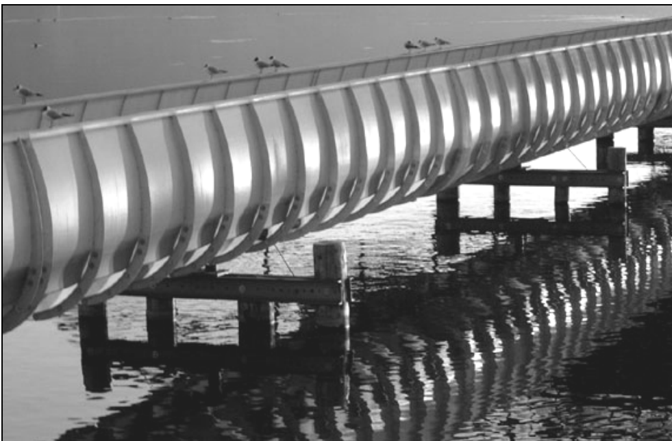
Bild 2.7: Brückenkonstruktion aus GFK [25]
