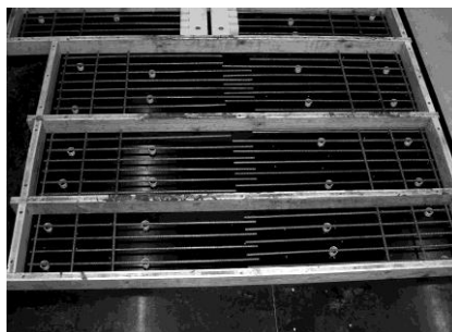
Abb. 7.2: Stabstahlbewehrung und gerade Stabenden
