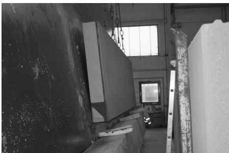
(h) Abheben des Wandelementes
