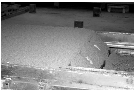
(f) Aufgefüllte Schalung
