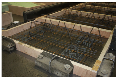
(a) Schalung, Bewehrung und Gitterträger - Schale 1
