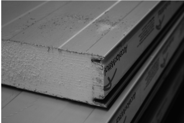
Abb. 3.1: Sandwichelement mit Metalldeckschichten und PUR-Kern
