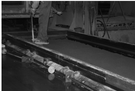
(a) Eingefüllte erste Betonlage
