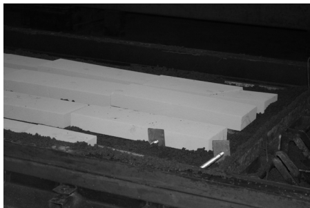
(c) Eingelegte Dämmkerne
