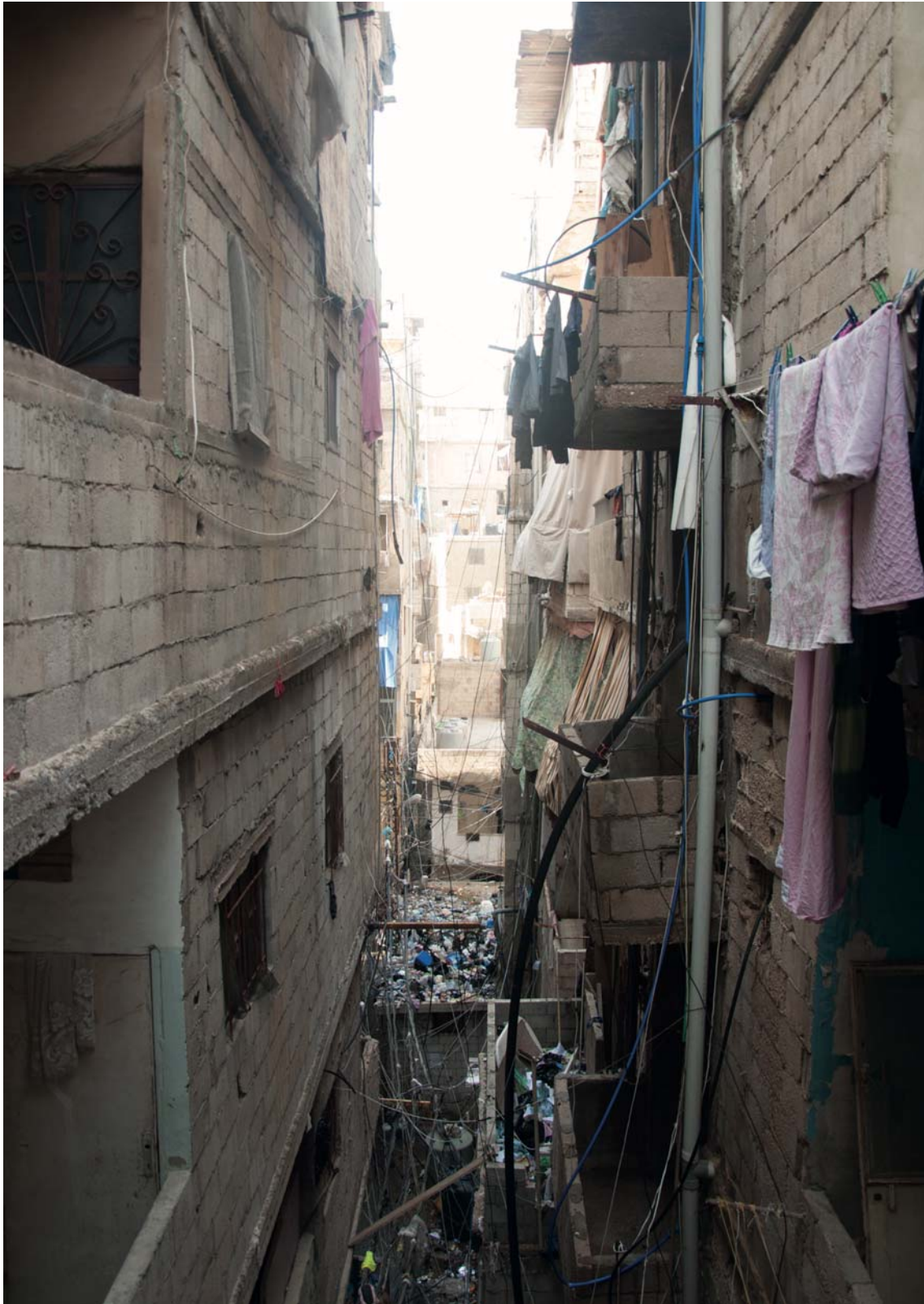
Abb 19 Korridore (Zwischenebenen und Müll)
