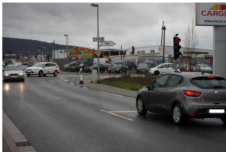
Abbildung 6.16: Teilsignalisierung am Knotenpunkt 1
