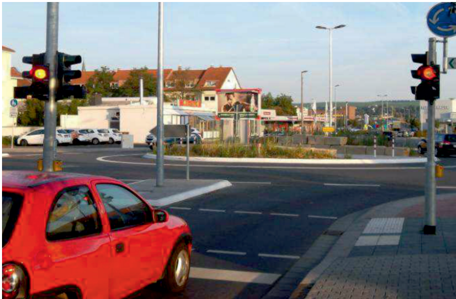
Abbildung 10.10: Fußgängerlichtsignalanlage am Kreisverkehr in Bad Kreuznach
