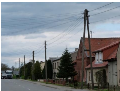
Abbildung 3: Beispiele für die zwei Varianten der Verlegeart von Freileitungen 3 (links: Strommast, rechts: Dachständer)
