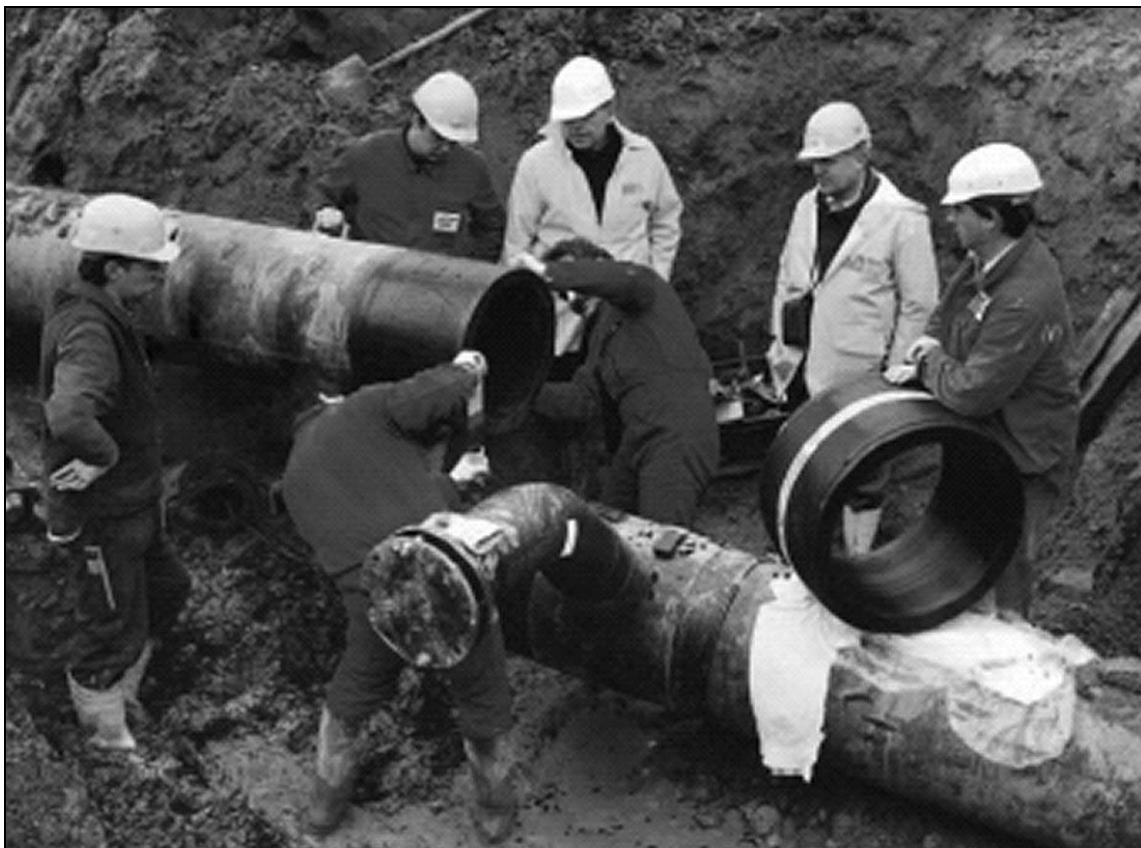
Bild 1.6: Rohrfitting der Firma Friatec (Frialen®) für thermoplastische Erdgasleitungen [20]
