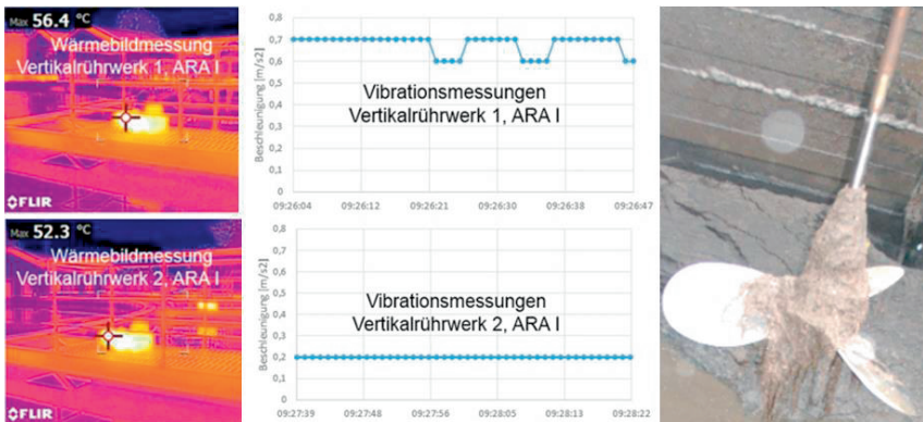
Abbildung 11: Einsatz einer Wärmebildkamera und einer Vibrationsmessung zur Zustandsüberwachung von Rührwerken (Bildquelle: Wiese und Hilfenhaus, 2016)
