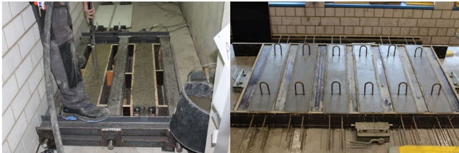
Abb. 3.44: Betonieren der Stahlbetonstäbe in dem Stahlrahmen zur Aufzeichnung der Zwangskraft infolge von Betonschwinden (links) und die noch in der Schalung liegenden Stahlbetonstäbe (bzw. ein Betonstab ohne Längsbewehrung) für Kurzzeitzugversuche sowie für Dauerstandversuche zur Aufzeichnung des Betonschwindens (rechts).
