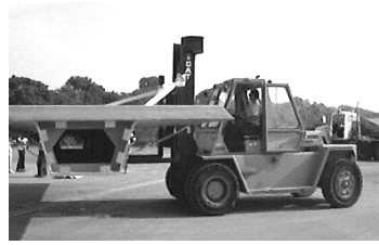
2. Entladen an der Baustelle
