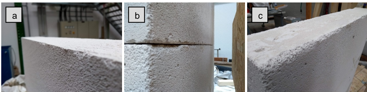
Abbildung 5.14: Keine (a), mittlere (b) und starke (c) Schädigung der Fuge im Knick
