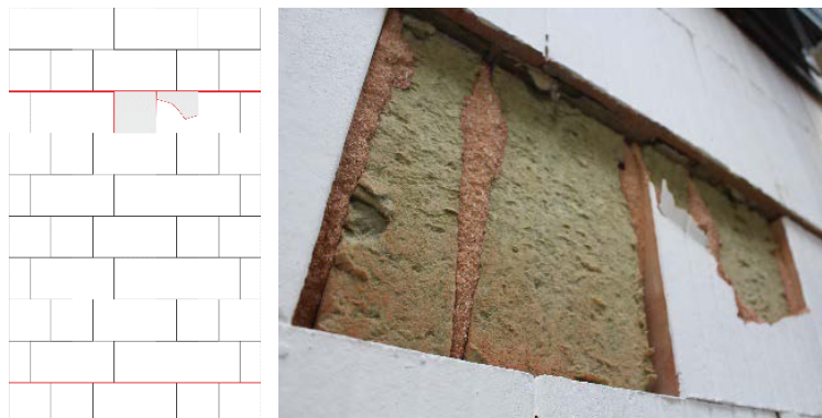
Abbildung 4.40: Abplatzungen der Steine in MZ70v2
