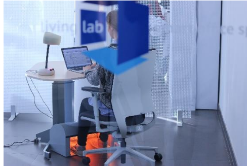
Abbildung 3-2: Dezentrale Heiz- und Kühlsysteme, Tischventilator, Fußwärmer, Bürostuhl mit Heiz- und Kühlfunktion
