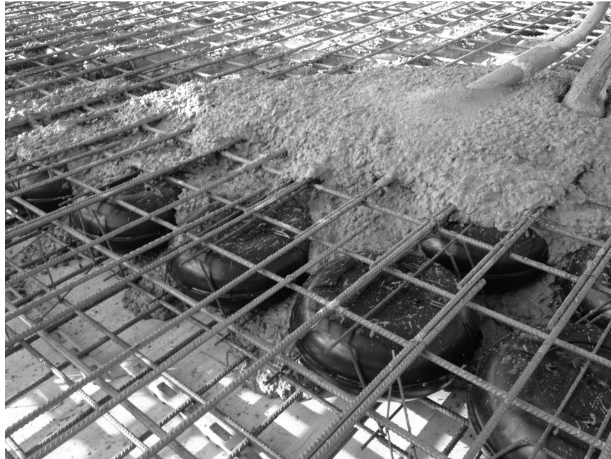
Abbildung 1.2: Hohlkörper in einer Stahlbetonflachdecke während der Betonage.
