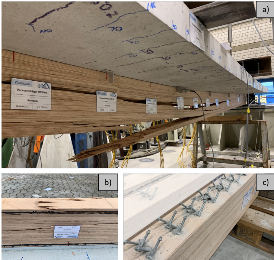
Abbildung 8-30: Versagensbild von Versuchsträger HBV100
