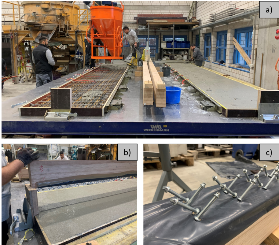
Abbildung 8-20: Betonage der Holz-Beton-Verbundträger
