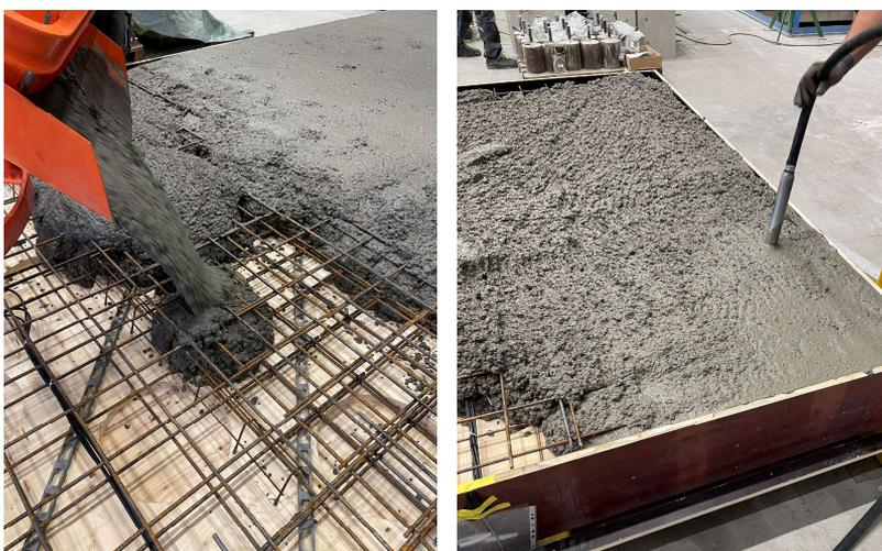
Abb. 6.3: Betonage des Probekörpers
