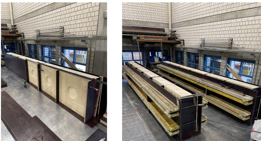
Abb. 5.3: Schalungsbau für die Betonage der Serie 1 im Labor für Konstruktiven Ingenieurbau der RPTU Kaiserslautern-Landau
