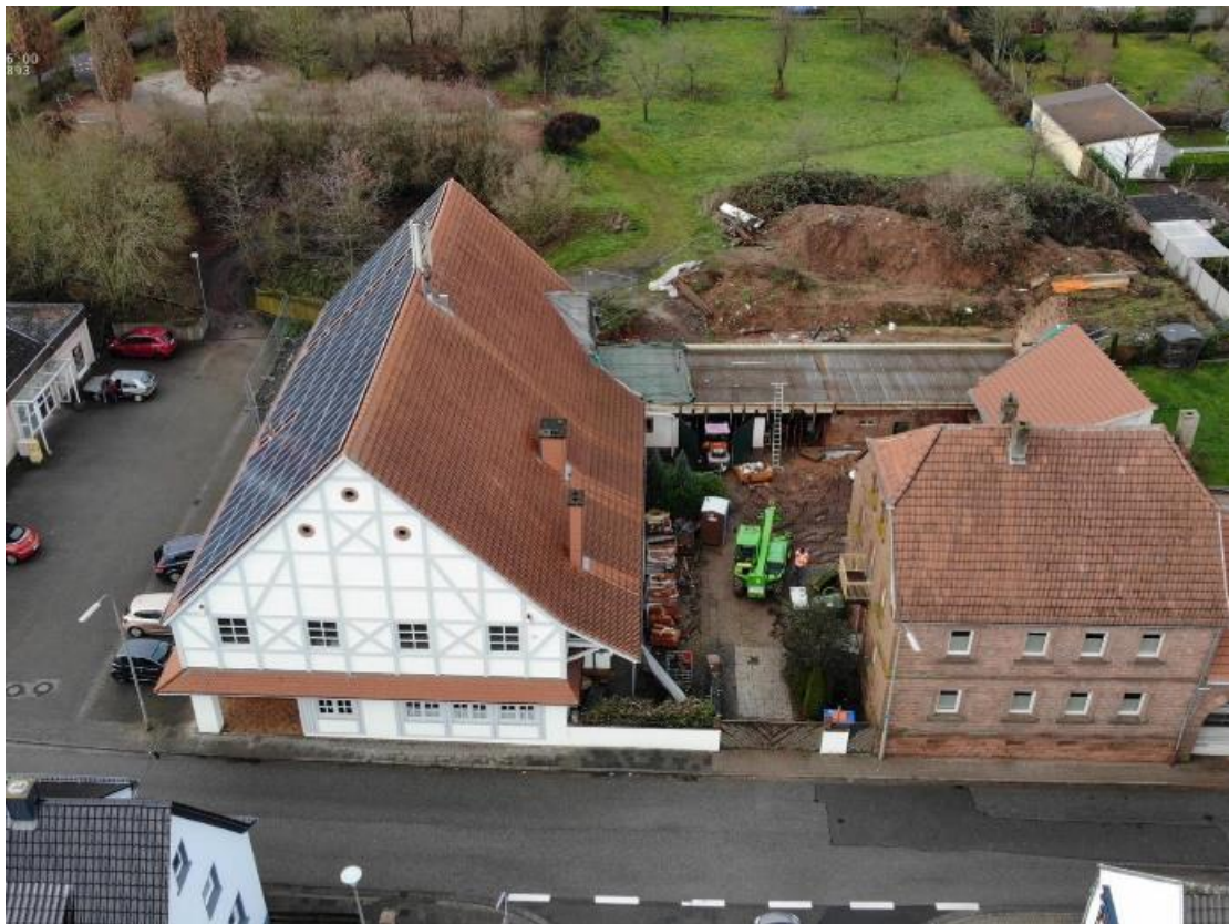
Abbildung 9: Ausgangszustand des Gebäudekomplexes [87]
