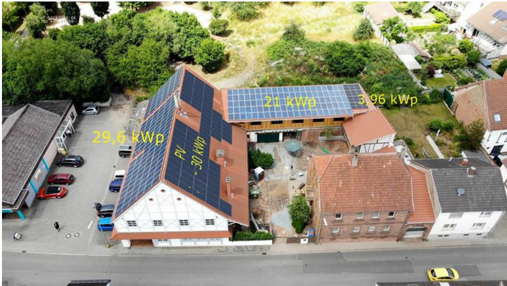
Abbildung 10: Gebäudekomplex nach erfolgreicher Umsetzung der Ferienwohnungen und Erweiterung der PV-Anlage [88]
