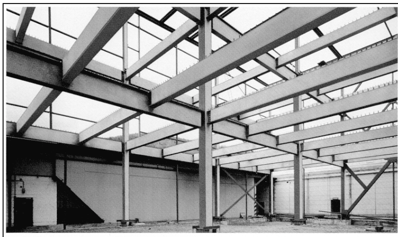
Bild 1.2 Deckenträger und Unterzüge (ohne Verbunddecke) im Montagezustand [1.1]
