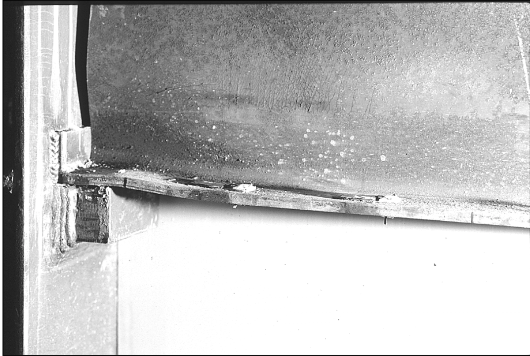
Bild 4.2 Trägerstegbeulen über der Auflagerknagge, Versuch T5-1
