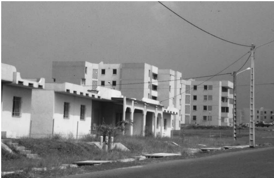
Neuzeitliche Siedlung in Yaounde-Kamerun
