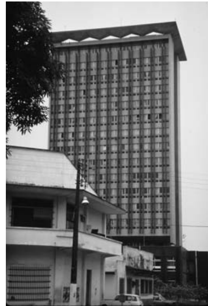
Verwaltungsgebäude in Douala-Kamerun mit vorgesetzter Glasfassade
