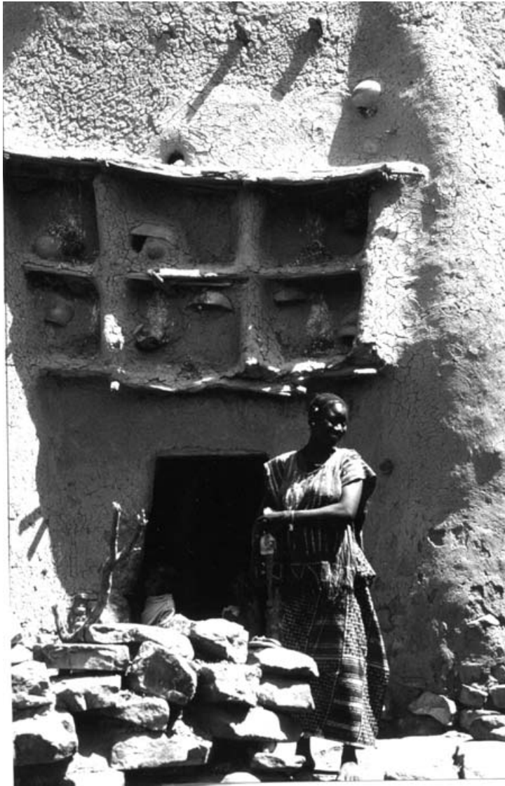
Eingang zur „Höhle“ der Hauses
